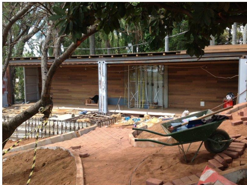
Figura 10: Obra seca que utiliza poucos equipamentos. Fonte: Jomar Bragança.
