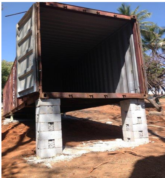
. Figura 7: Fundação da Pocket House . Fonte: Jomar Bragança.
