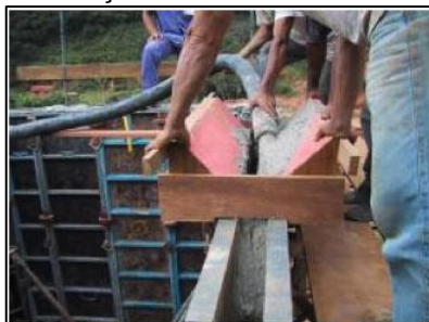
Figura 19: Lançamento do concreto nas fôrmas.
