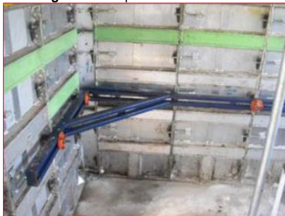
Figura 17: Esquadro de travamento.
