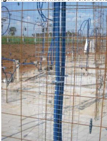
Figura 4: Tela armada em eletrodutos.
