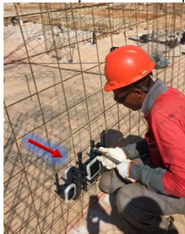
Figura 25: Execução da instalação de caixas de passagem nas telas.
