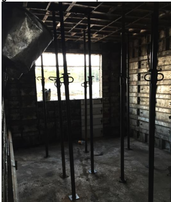
Figura 31: Fôrmas de um apartamento escoradas.
