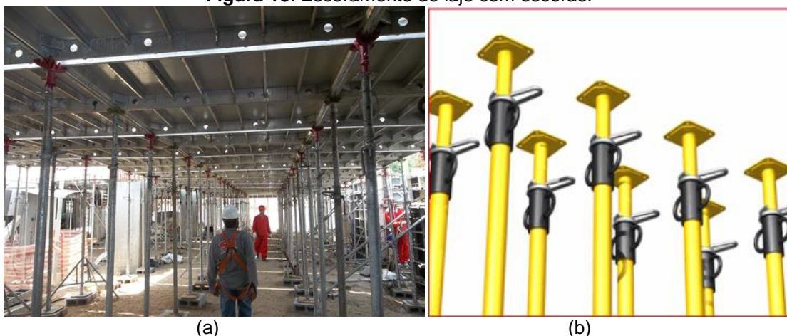
Figura 13: Escoramento de laje com escoras.
