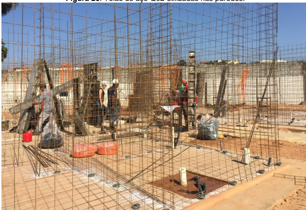
Figura 23: Telas de aço Q92 utilizadas nas paredes.
