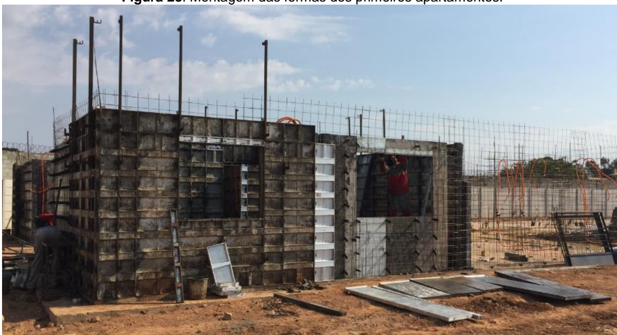
Figura 28: Montagem das formas dos primeiros apartamentos.
