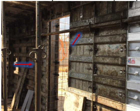
Figura 30: Escoras das lajes e alinhadores de parede já travados
