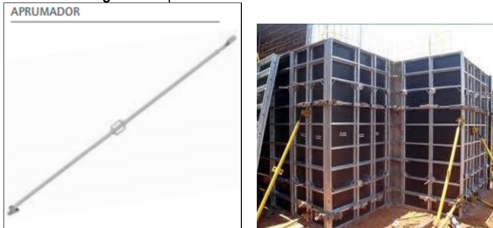
Figura 16: Aprumador usado em fôrmas de alumínio
