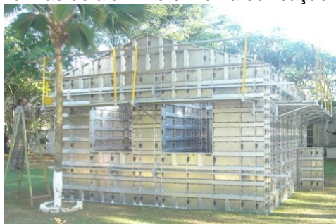
Figura 7: Fôrmas de alumínio em uma edificação residencial.
