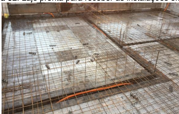
Figura 32: Laje pronta para receber as instalações elétricas.
