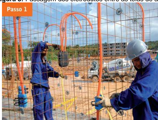
Figura 3: Passagem dos eletrodutos entre as telas de aço.
