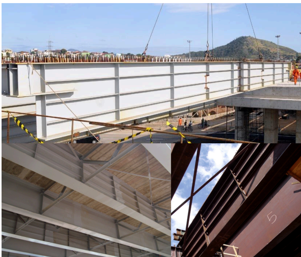
Figura 1-2. Construção de pontes e viadutos em Belo Horizonte (MG) e Vila Velha (ES) a partir de vigas esbeltas de aço com seção transversal do tipo I reforçadas por enrijecedores transversais e longitudinais. Fonte: RMG Engenharia
