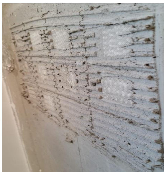
Figura 10 Espessura da aplicação das argamassas
