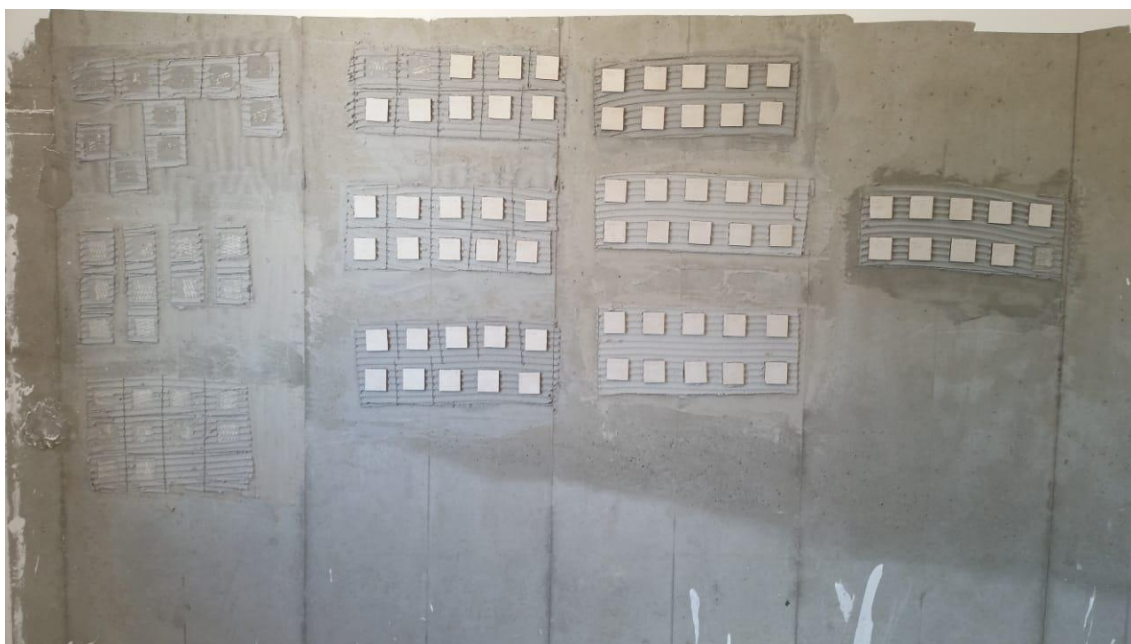
Figura 11 Assentamento dos revestimentos cerâmicos nas argamassas colantes
