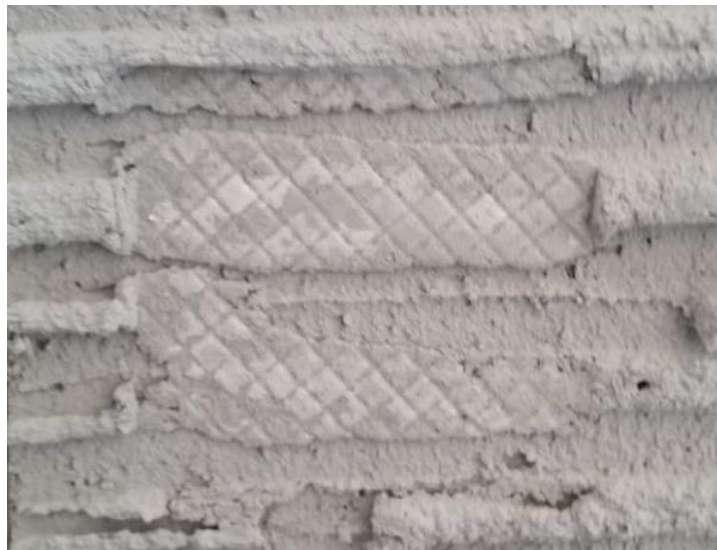
Figura 17 Face da parede de concreto não lavada após ruptura - Argamassa do fabricante 3 do tipo AC-III.
