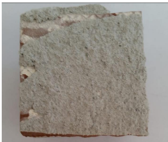
Figura 20 Ruptura do revestimento cerâmico utilizando a argamassa fabricante 1 do tipo AC-II.
