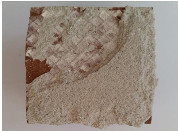
Figura 14 Ruptura do revestimento cerâmico utilizando a argamassa do fabricante 3 do tipo C2.
