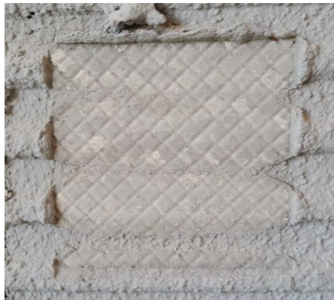
Figura 29 Face da parede de concreto não lavada após ruptura - Argamassa do fabricante 2 do tipo AC-III.
