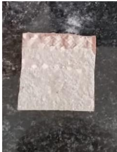
Figura 12 Ruptura do revestimento cerâmico utilizando a argamassa do fabricante 3 do tipo AC-I.
