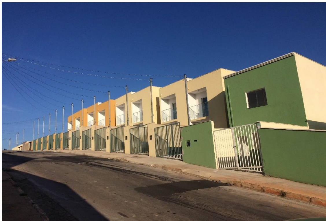
Figura 22: Unidades executadas na quadra 5 do Bairro Santa Rita
