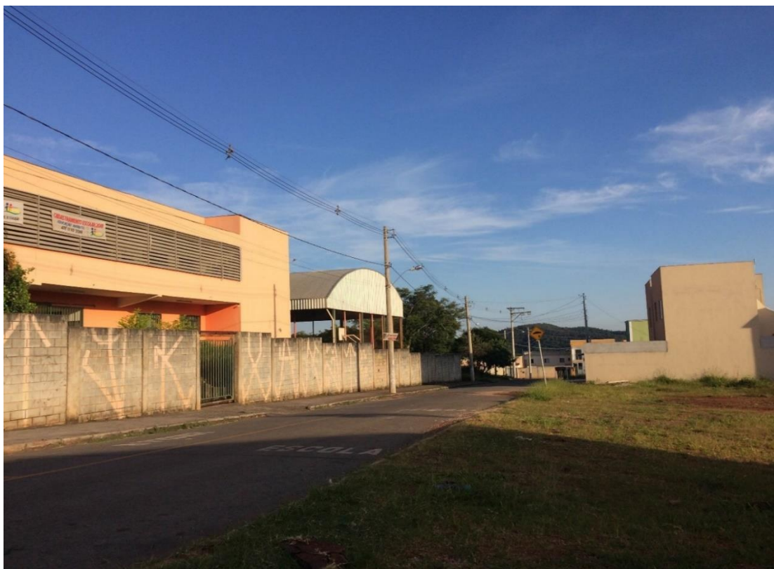
Figura 23: Escola municipal, loteamento para implantação da praça e casas já executadas
