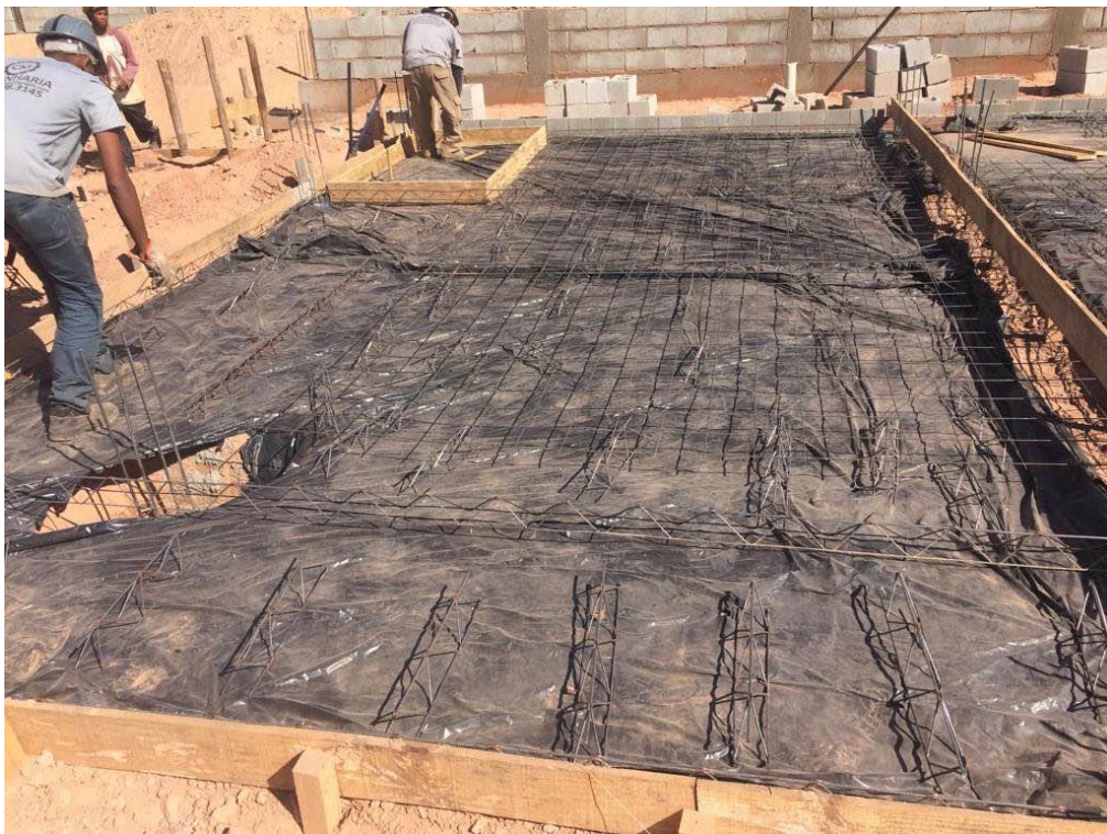
Figura 15: Fôrma, armação do radier e preparação para concretagem
