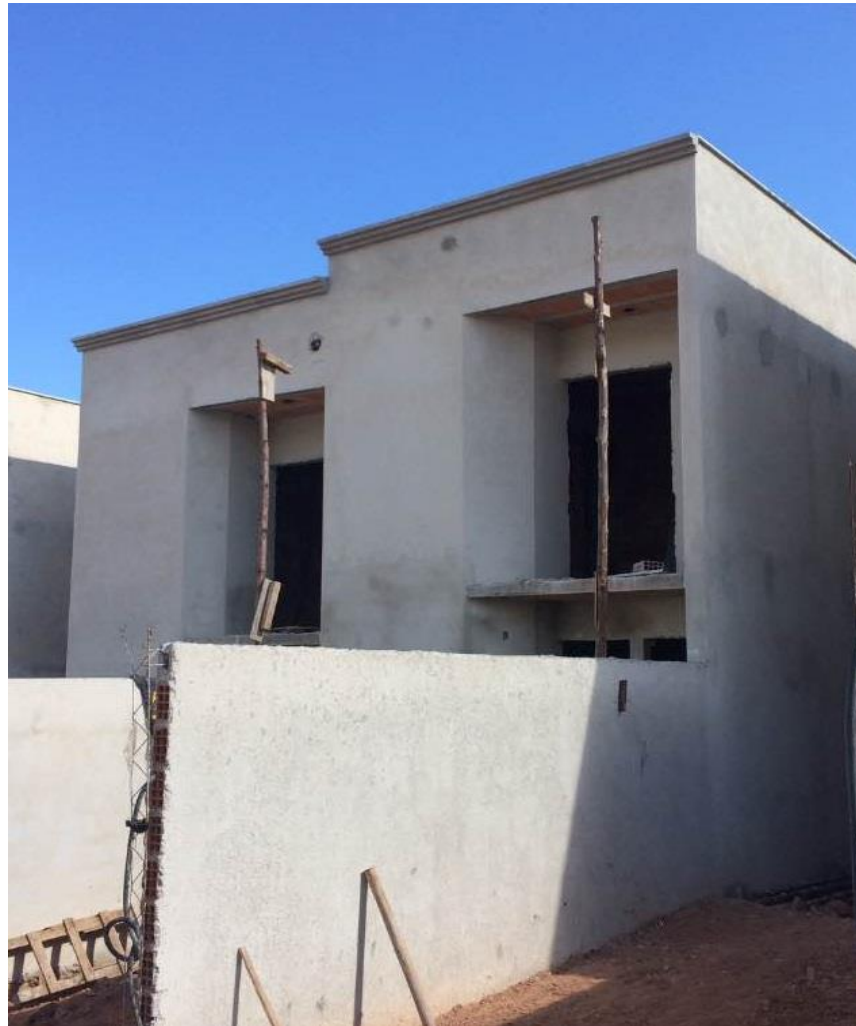
Figura 17: Revestimento externo em reboco
