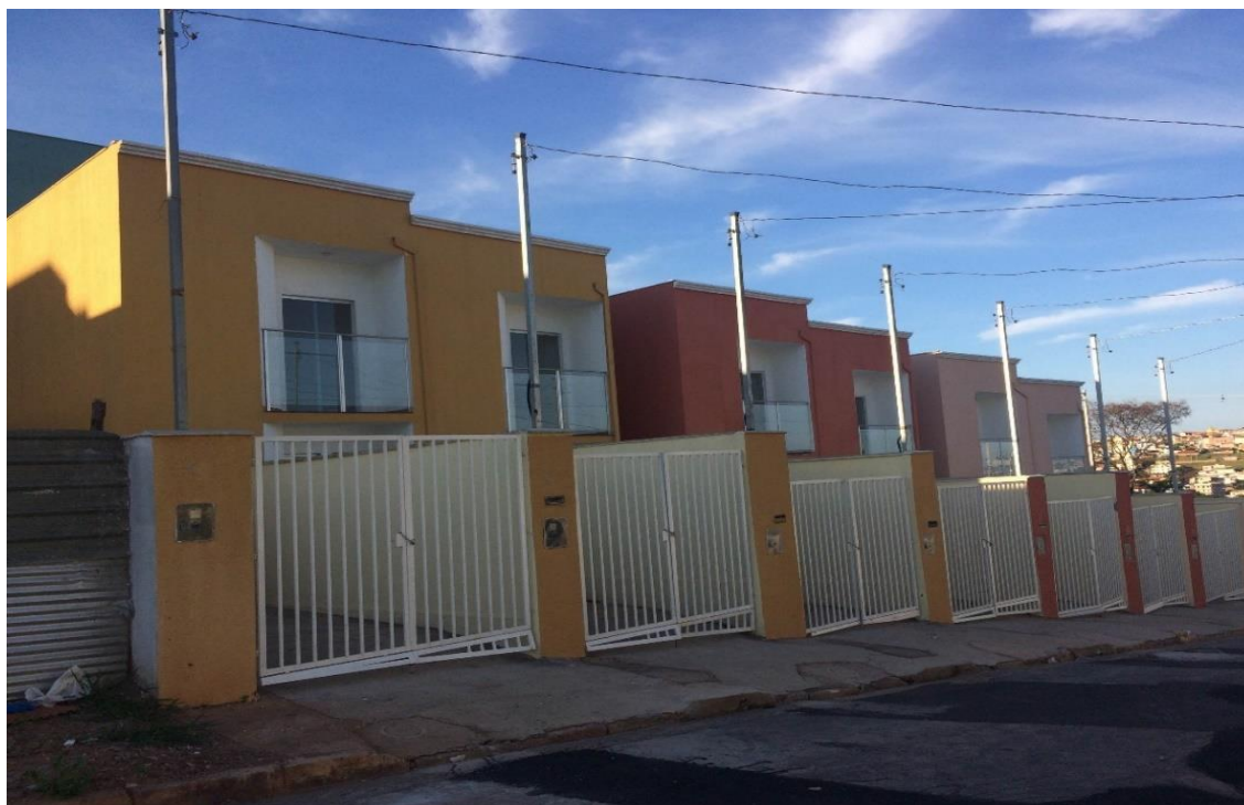
Figura 21: Unidades executadas na quadra 4 do Bairro Santa Rita
