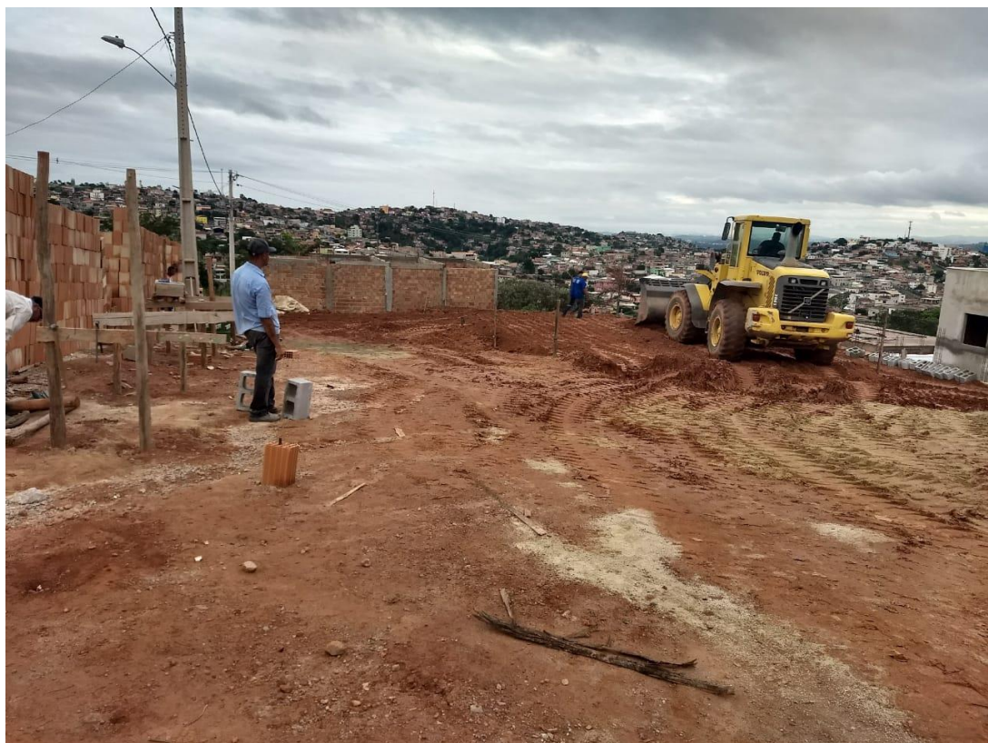
Figura 14: Movimentação de terra com máquina carregadeira
