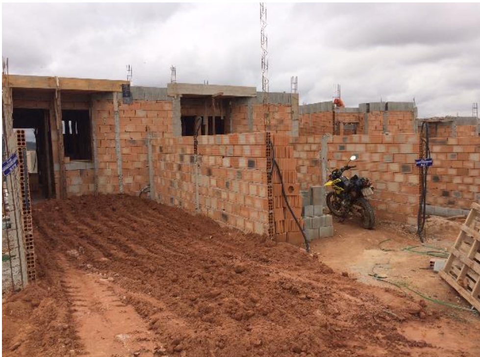
Figura 16: Alvenaria em tijolo cerâmico
