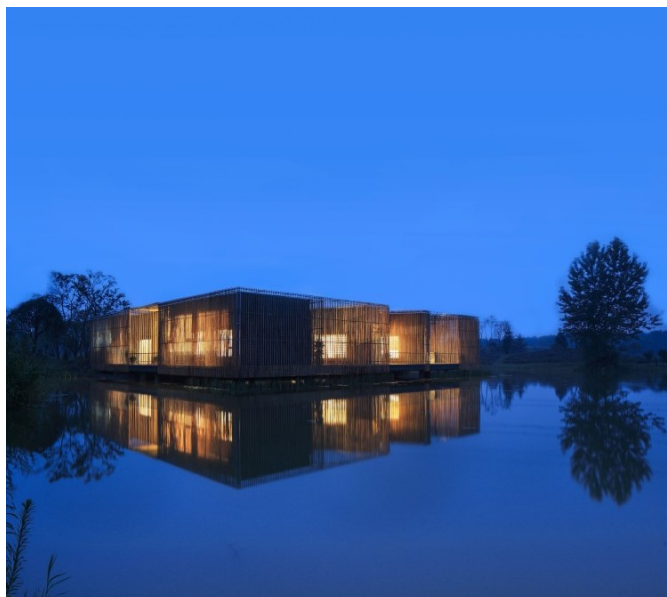
Figura 8 – Vista de toda construção
