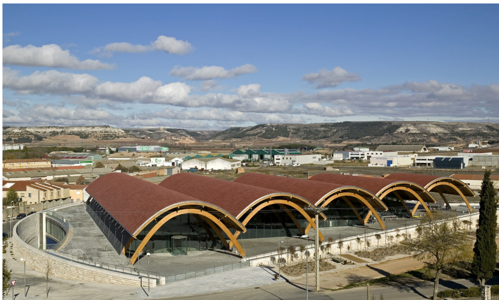
Figura 22 – Vista da cobertura
