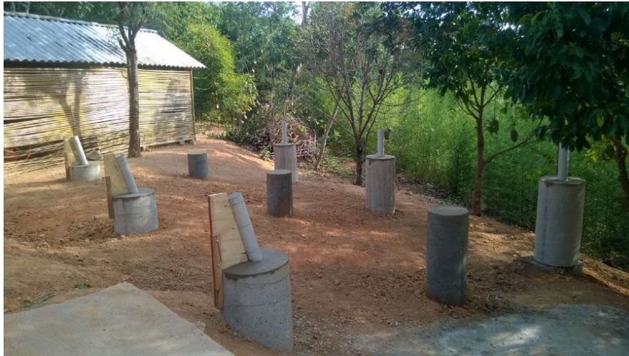
Figura 9 – Fundação de concreto para encaixe dos bambus roliços
