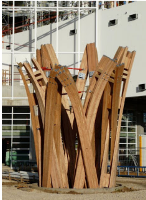
Figura 18 – Detalhe da construção da estrutura de sustentação
