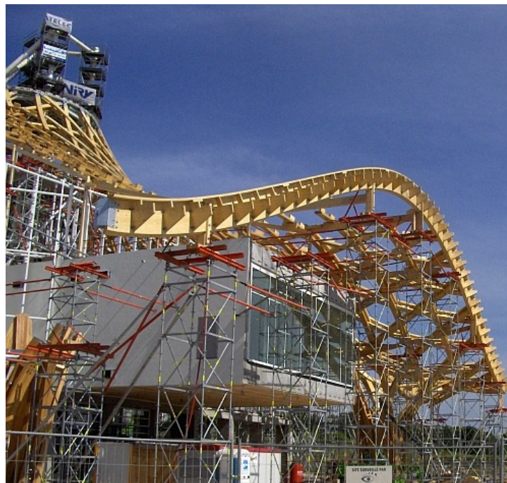
Figura 19 – Sistema versátil de escoramento da cobertura
