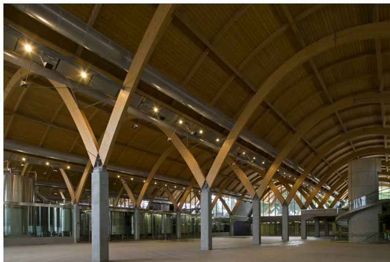
Figura 20 –Vista interna da estrutura
