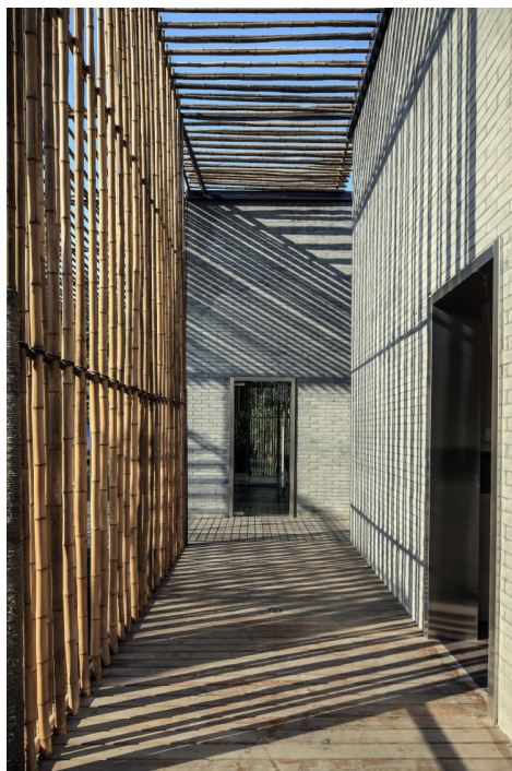
Figura 7 – Solidarização de diferentes materiais associados ao bambu
