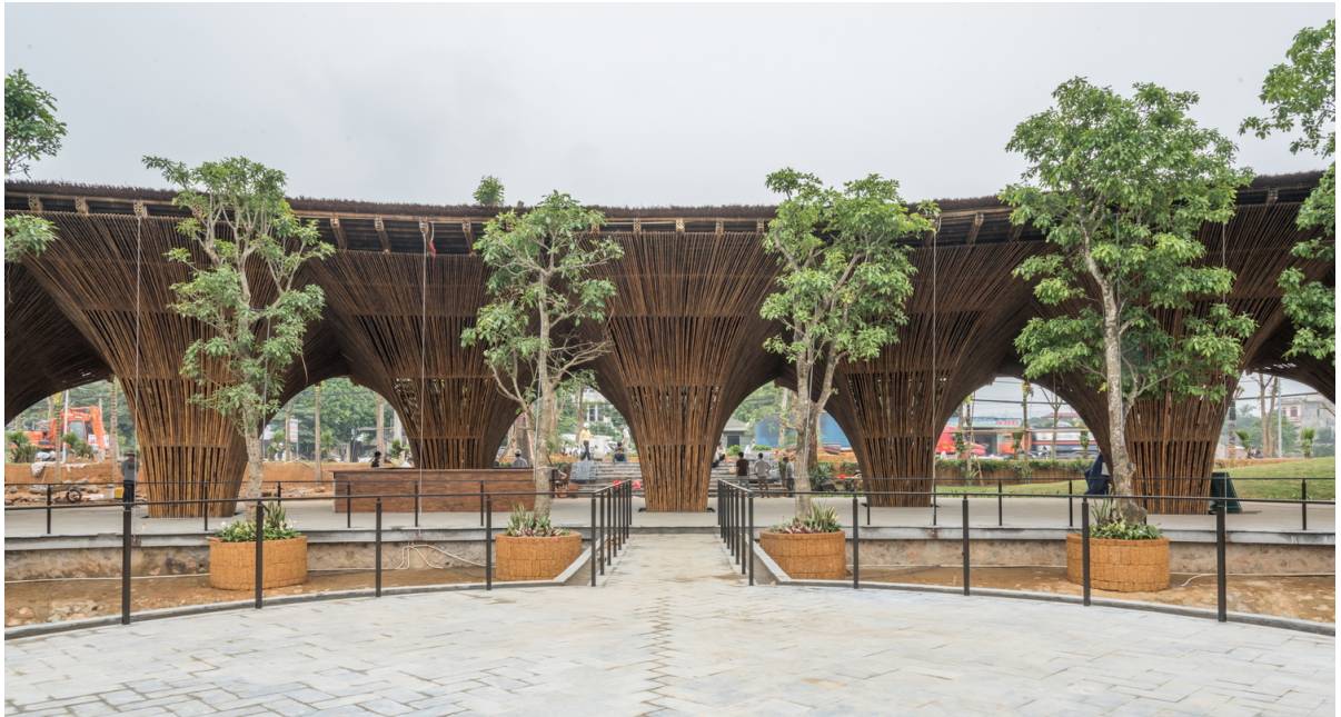
Figura 13 – Estrutura de bambu do Restaurante Roc Von
