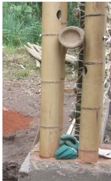
Figura 1 –Detalhes de fundação de uma estrutura de bambu rolido
