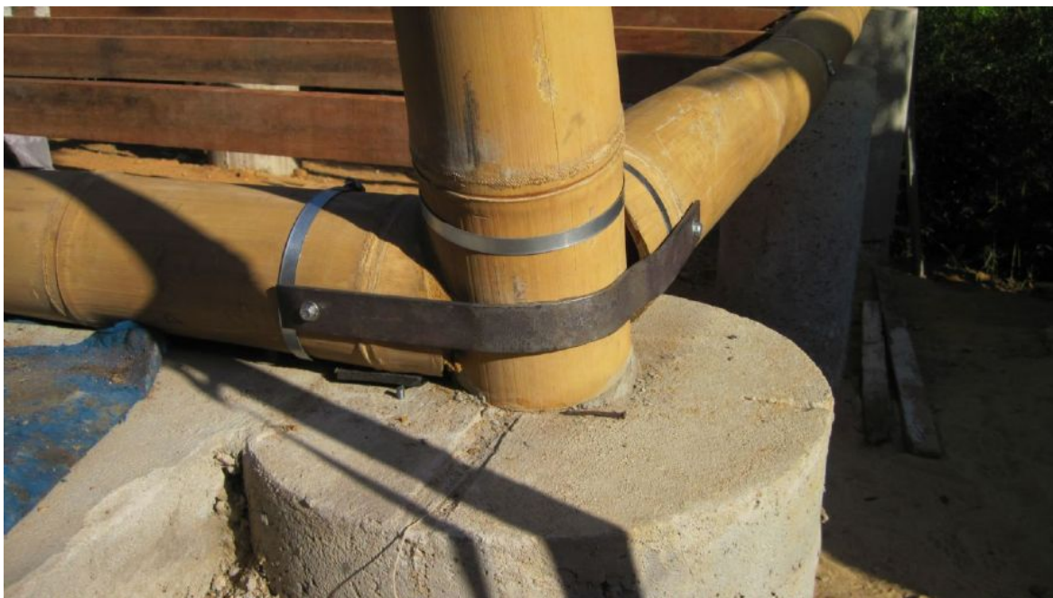
Figura 11 –Encaixe formato boca de peixe
