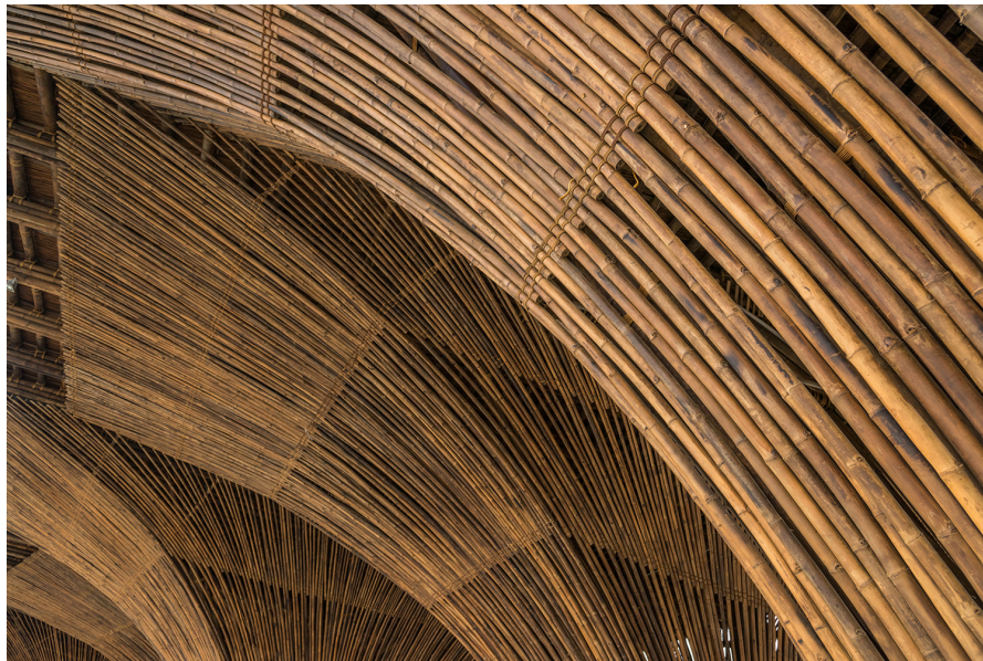
Figura 12 – Detalhe da conexão das varas de bambu
