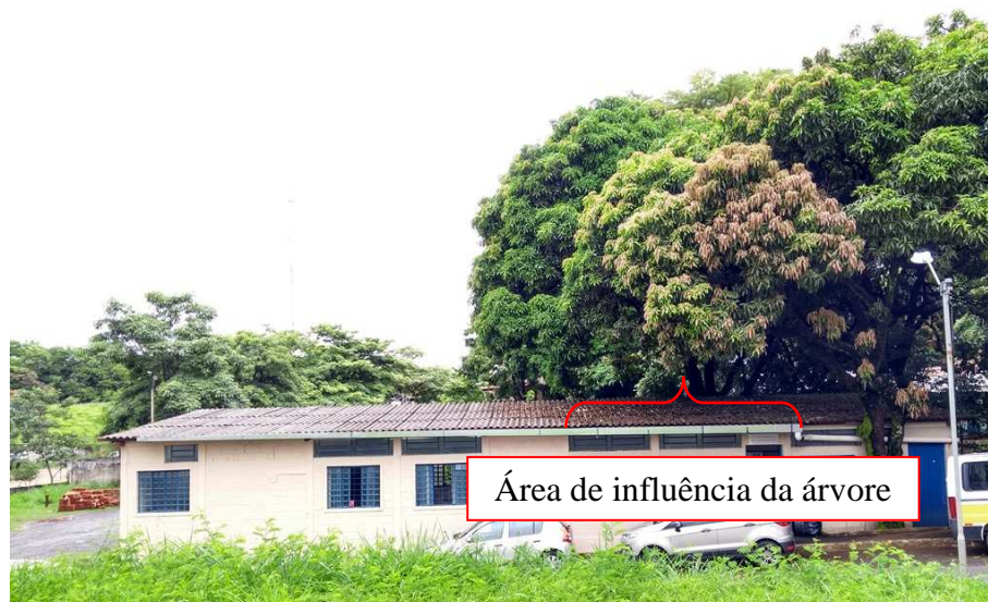
Figura 7.39: Árvore existente próxima ao telhado do experimento M-RNE
