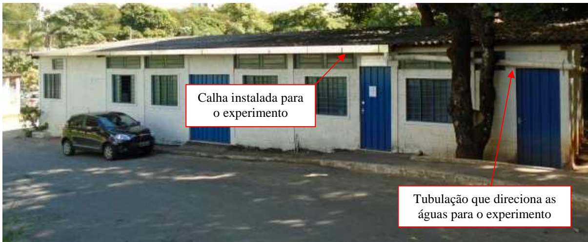
Figura 7.18: Telhado da edificação da Gerência Distrital da Vigilância Sanitária, onde serão coletadas as águas de chuva
