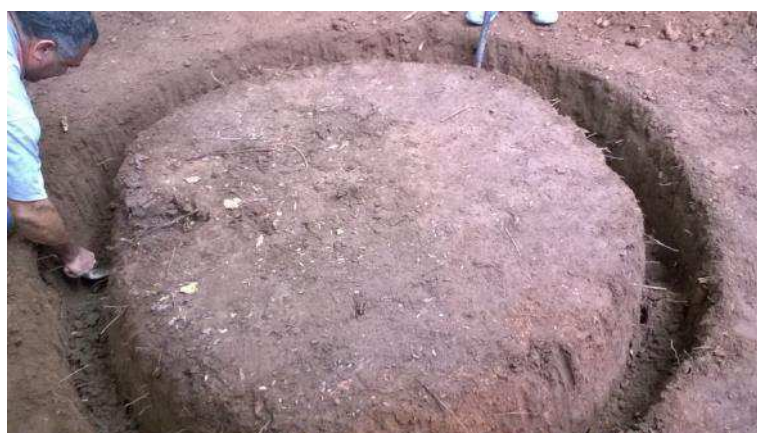
Figura 7.21: Vala construída para assentamento do tanque na Regional Nordeste
