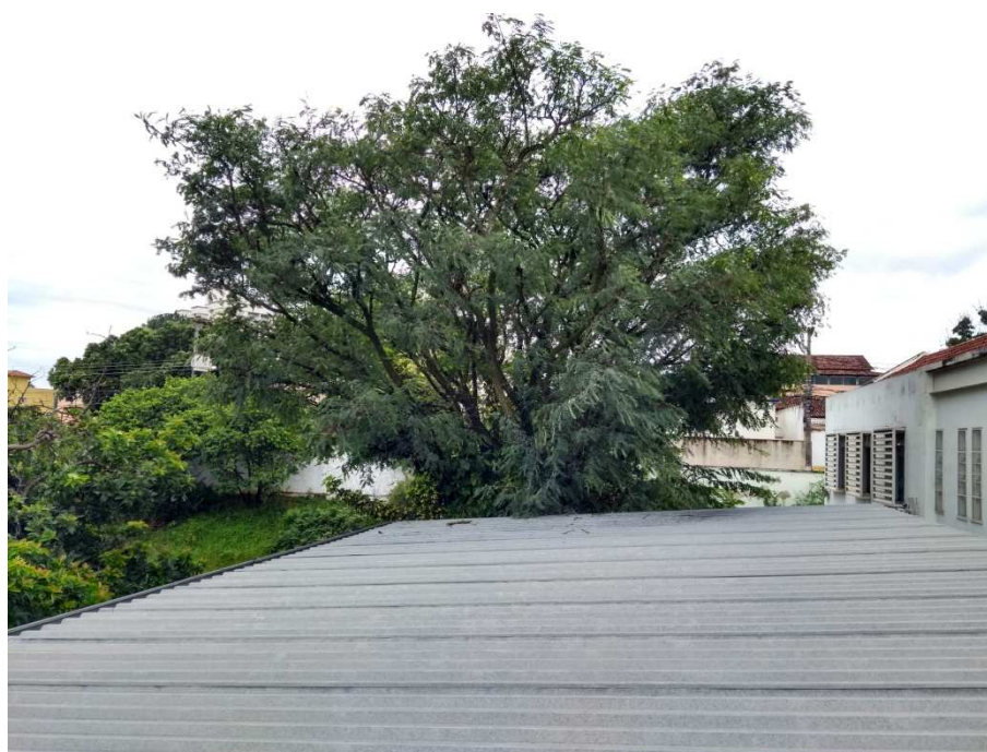
Figura 7.38: Árvore existente próxima ao telhado do experimento M-CS
