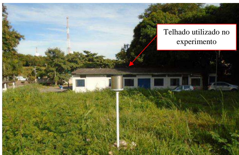
Figura 7.24: Pluviômetro instalado na Sede da Regional Nordeste
