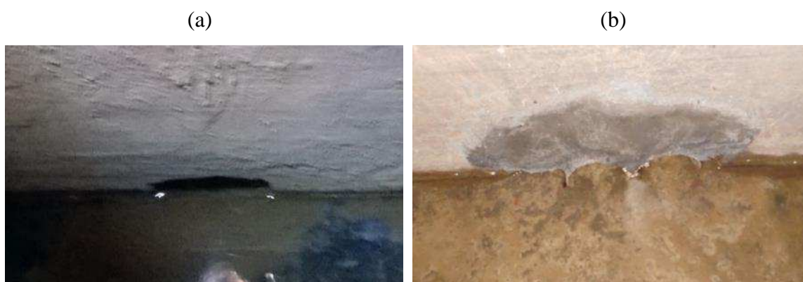
Figura 6.5: Estruturas de descargas monitoradas no MH (a) Tubo DN 200 (b) 2 x Tubos DN 100
