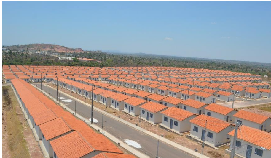
Figura 2 – Conjunto Habitacional MCMV
