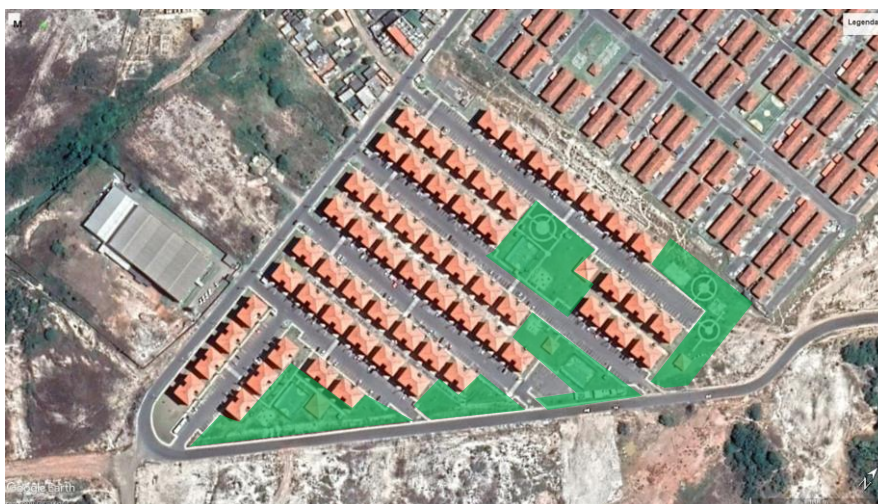
Figura 7 - Vista aérea de empreendimentos habitacionais em Camaçari, Bahia
