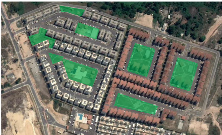
Figura 6 - Vista aérea de empreendimentos habitacionais em Camaçari, Bahia
