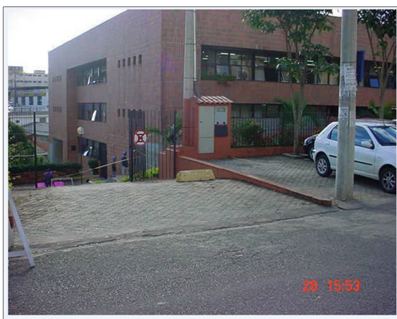
FIGURA 27: Fachada Frontal do Edifício “B”
