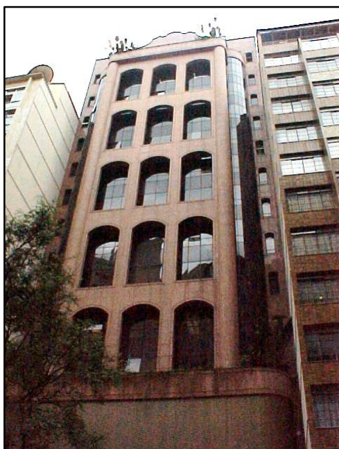
FIGURA 20: Fachada Frontal do Edifício “A”
