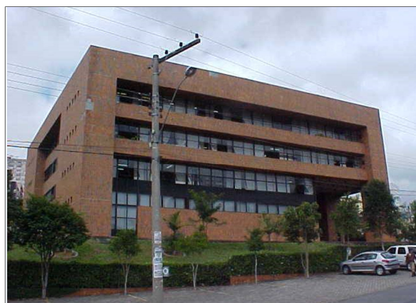
FIGURA 28: Fachada Posterior do Edifício “B”
