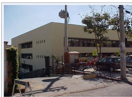
FIGURA 35: Fachada depois da Reforma
