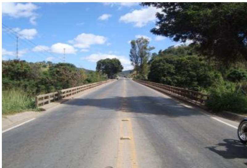
Figura 28 - Vista superior sentido Sabará - BR-262 - (lado Sabará).
