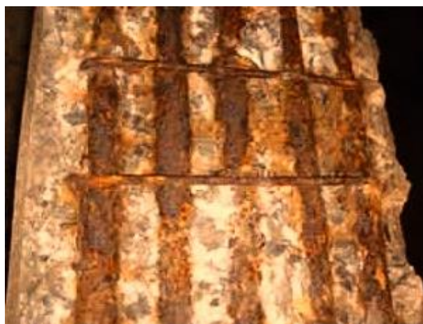
Figura 12 - Ação dos íons cloreto ( \text{Cl}^- )
