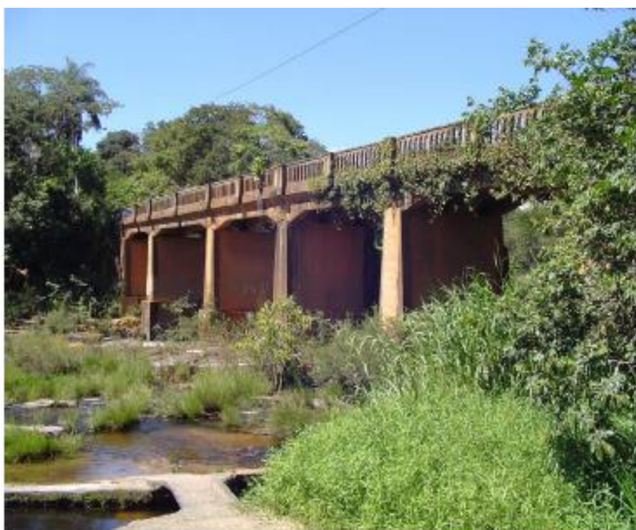
Figura 16 - Vista lateral esquerda da Ponte sob Rio Cipó sentido Jaboticatubas - Cardeal Mota.
