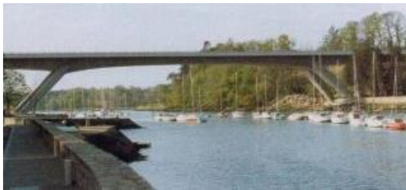
Figura 5 - Ponte em quadro rígido, Ponte St. Goustan
