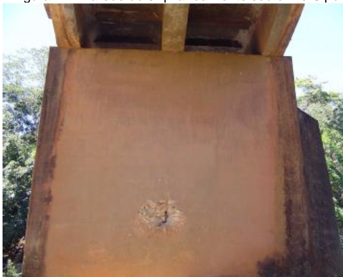
Figura 22 - Parede do 3º pilar da Ponte sob o Rio Cipó
