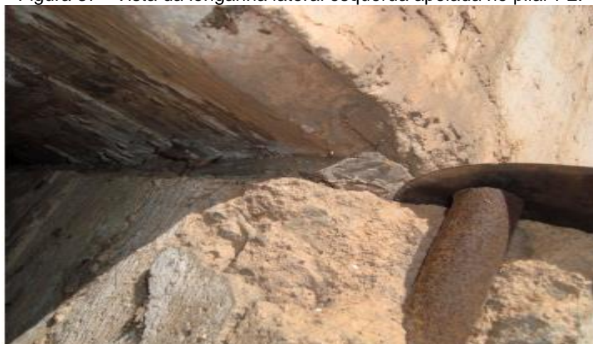
Figura 37 - Vista da longarina lateral esquerda apoiada no pilar P2.
