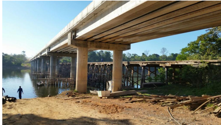
Figura 4 - Ponte em laje
