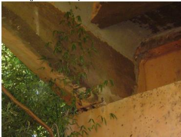
Figura 21 - Longarina lateral esquerda do 6º vão da Ponte sob o Rio Cipó
