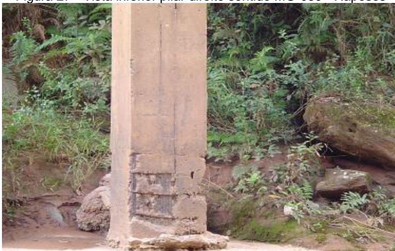
Figura 27 - Vista inferior pilar direito sentido MG-030 - Raposos
