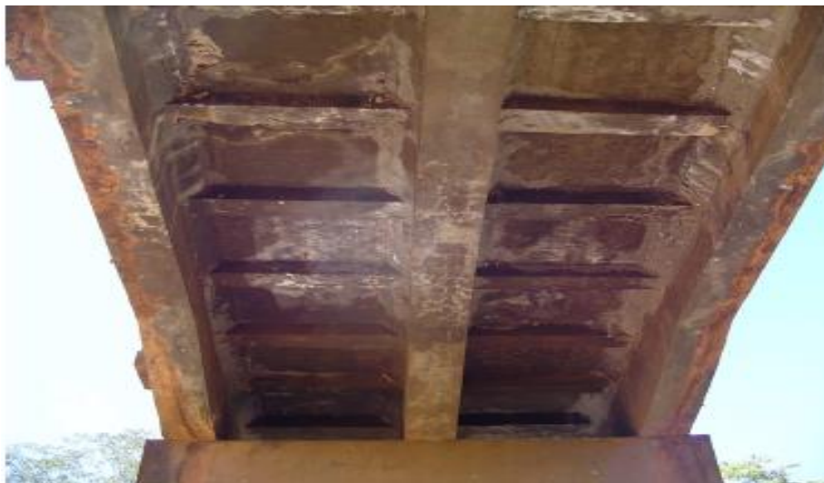
Figura 17 - Vista inferior (da laje do 3º vão) sentido Jaboticatubas - Cardeal Mota
