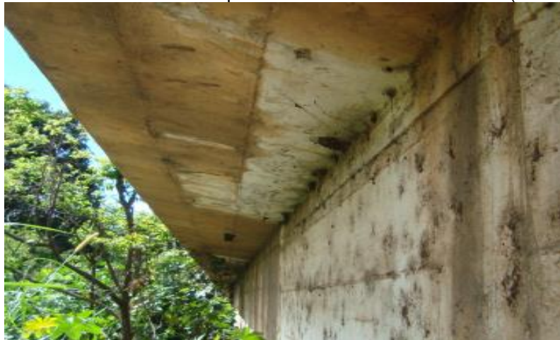
Figura 30 - Vista inferior lateral esquerda sentido BR-262 - Sabará - (lado BR-262).
