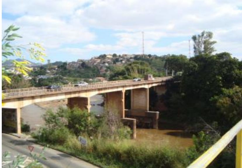
Figura 29 - Vista lateral esquerda sentido Sabará - BR-262 - (lado Sabará).
