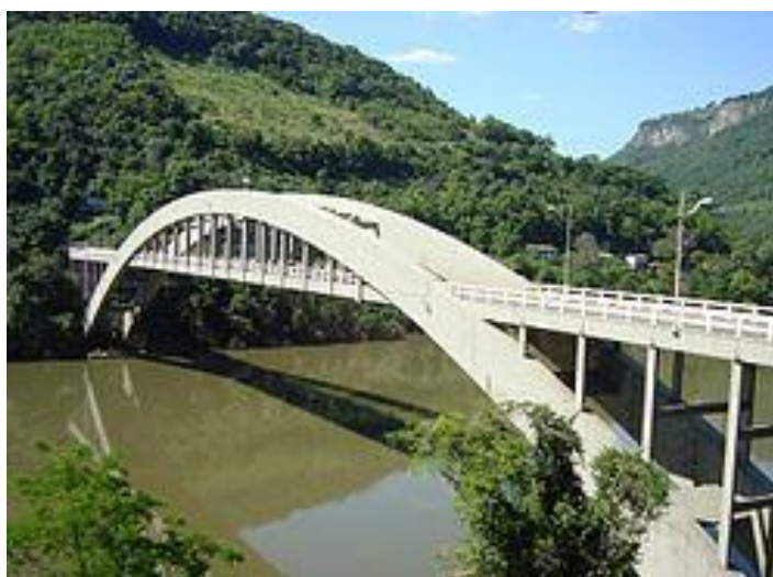
Figura 6 - Ponte Ernesto Dornelles ou ponte do Rio das Antas
