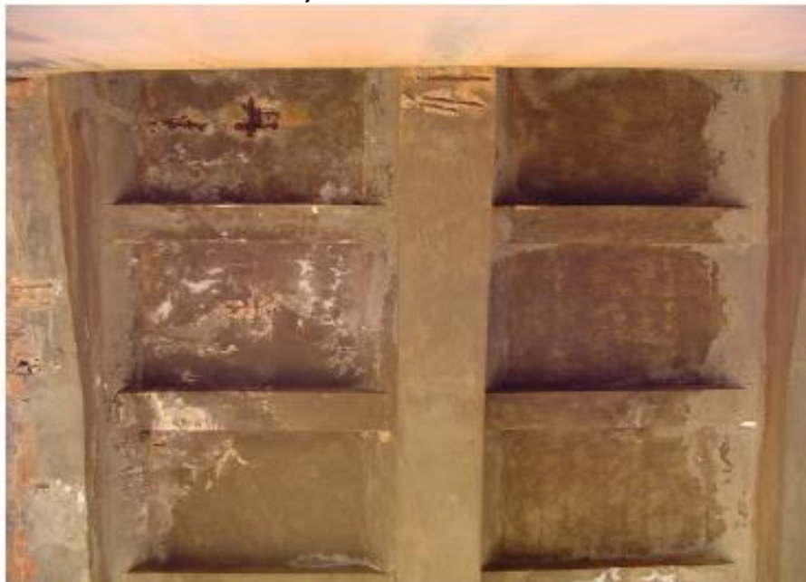
Figura 18 - Vista inferior 2 da laje do 3º vão sentido Jaboticatubas - Cardeal Mota
