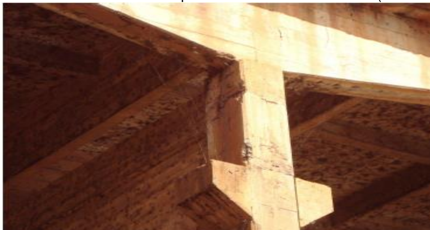
Figura 36 - Vista inferior lateral esquerda sentido Sabará - BR-262 (lado Sabará).
