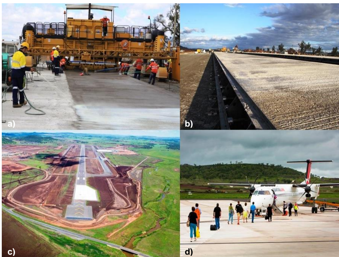
Figura 26: a) Cura do pavimento geopolimérico, b) concretagem finalidade, c) vista geral da pista do aeroporto do BWWA e d) operação do aeroporto BWWA
