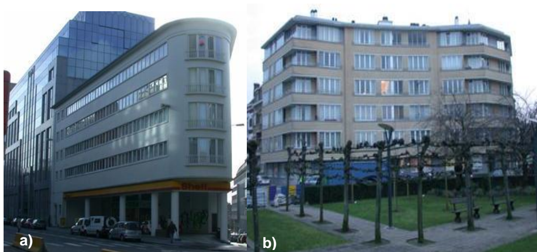
Figura 1: Edifícios em Bruxelas construídos com cimento de escória ativado alcalinamente: a) Localizado na esquina da Rua Breydel nº 9 e avenida Oudergem nº 15, b) Localizado na rua King Victor Square N os 12 e 13 Fonte: Buchwald, Vanooteghem, et al. (2013)
