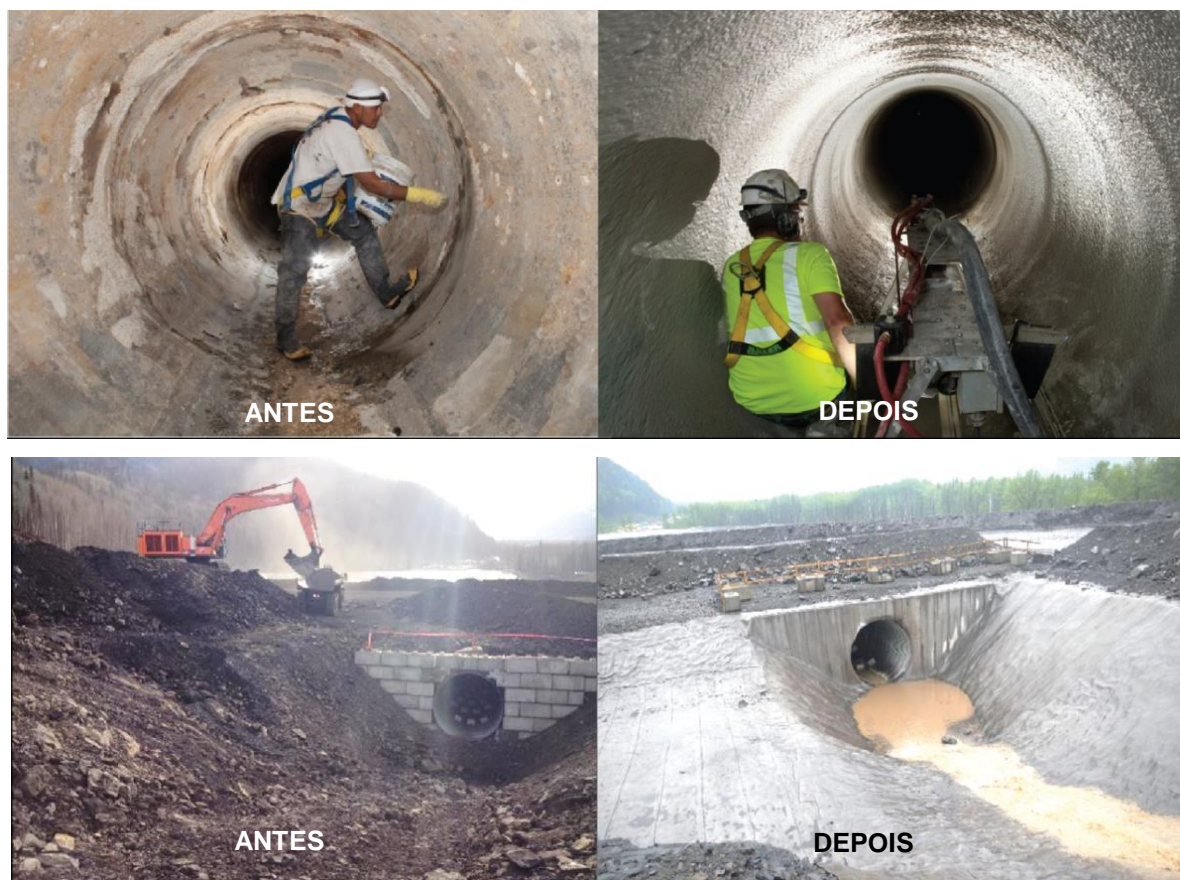
Figura 23: Aplicação de produtos geopoliméricos de revestimento de concretos deteriorados
