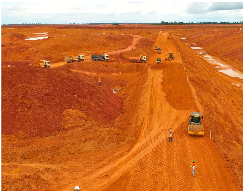
Figura 4. Exemplo obra construção pesada para implantação de uma barragem
