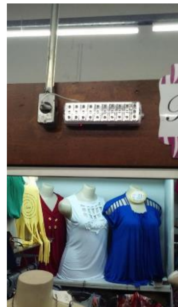
Figura 5.17: a) Localização Extintor; b) Abrigo de Hidrante; c) Iluminação de Emergência
