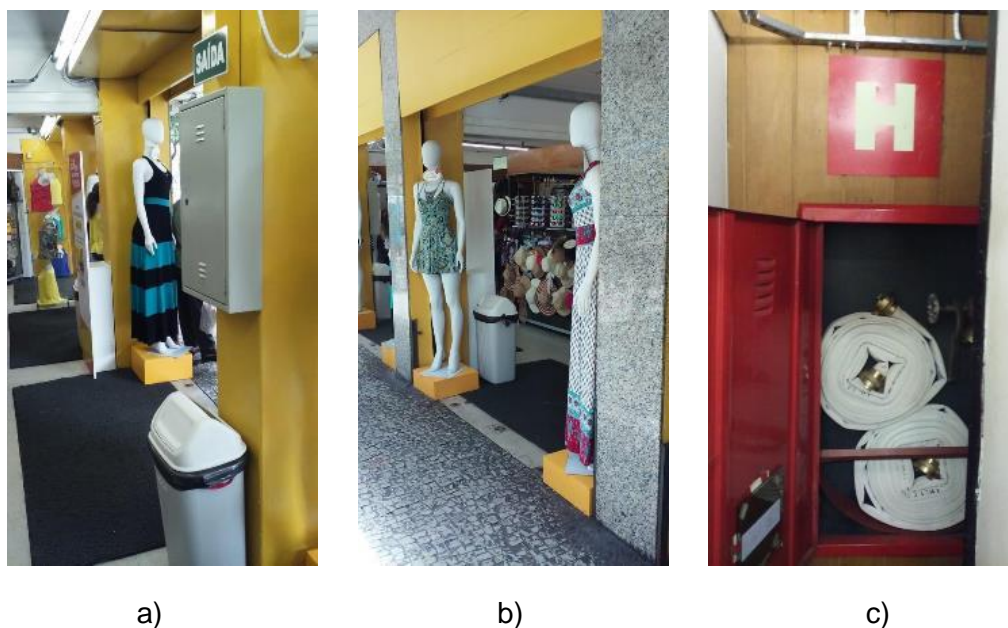
Figura 5.14: a) Acesso interno a Loja Comercial; b) Acesso externo a Loja Comercial; c) Hidrante
