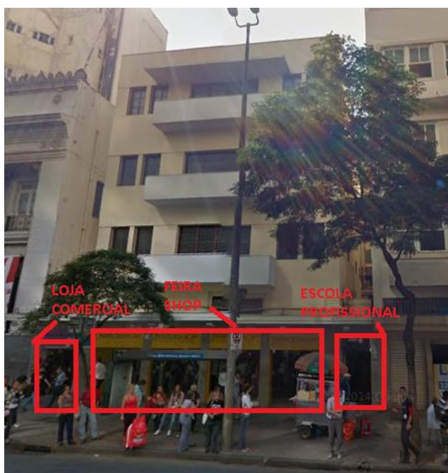
Figura 5.2: Fachada do edifício analisado
