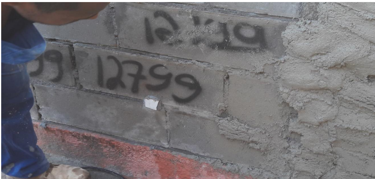
Figura 12 – Aplicação da argamassa de emboço no bloco de concreto. Fonte: (autor)
