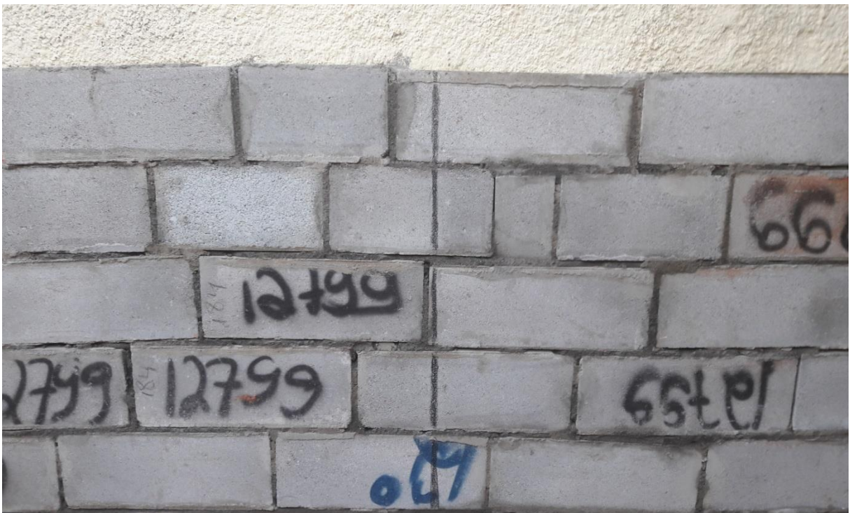
Figura 6 – Parede estrutural para o recebimento do sistema de revestimento. Fonte:
