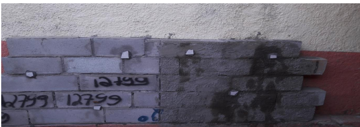
Figura 10 – Uso das taliscas no painel de teste. Fonte: (autor)
