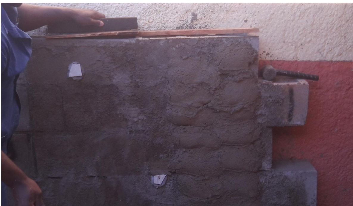
Figura 11 – Aplicação da argamassa de emboço no chapisco. Fonte: (autor)
