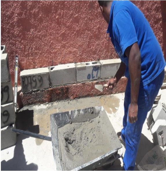
Figura 5 (a) - Assentamento dos blocos. Figura 5 (b) – Betoneira utilizada.
