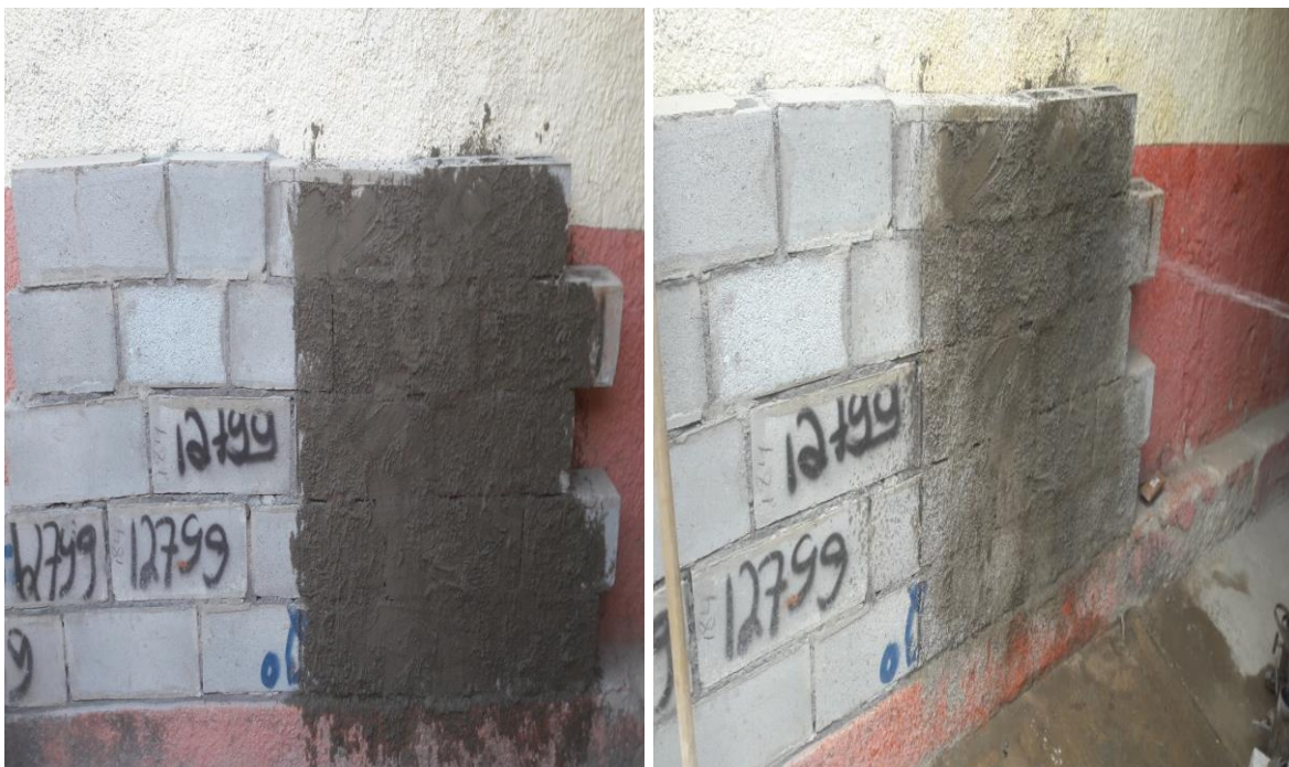
Figura 9 (a) – Aplicação do chapisco.
