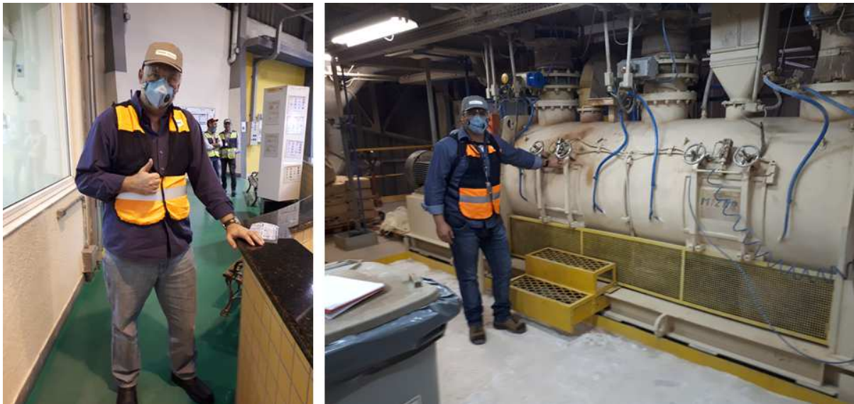
Figura 4 - Foto do galpão de produção e do misturador dos agregados.
