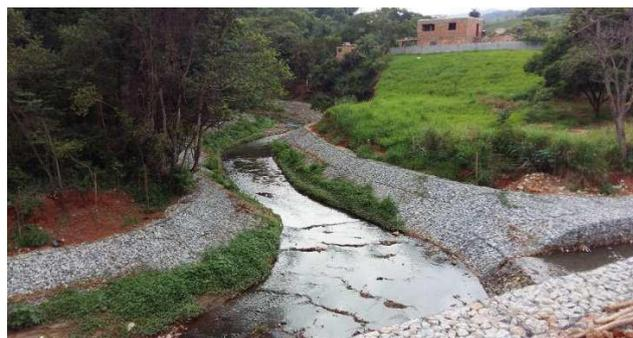
2 – Tratamento de trecho do córrego Bonsucesso na confluência com o córrego da Rua Marselhesa: revestimento da calha menor com Colchão Reno, para proteção contra erosões e revegetação das margens.
