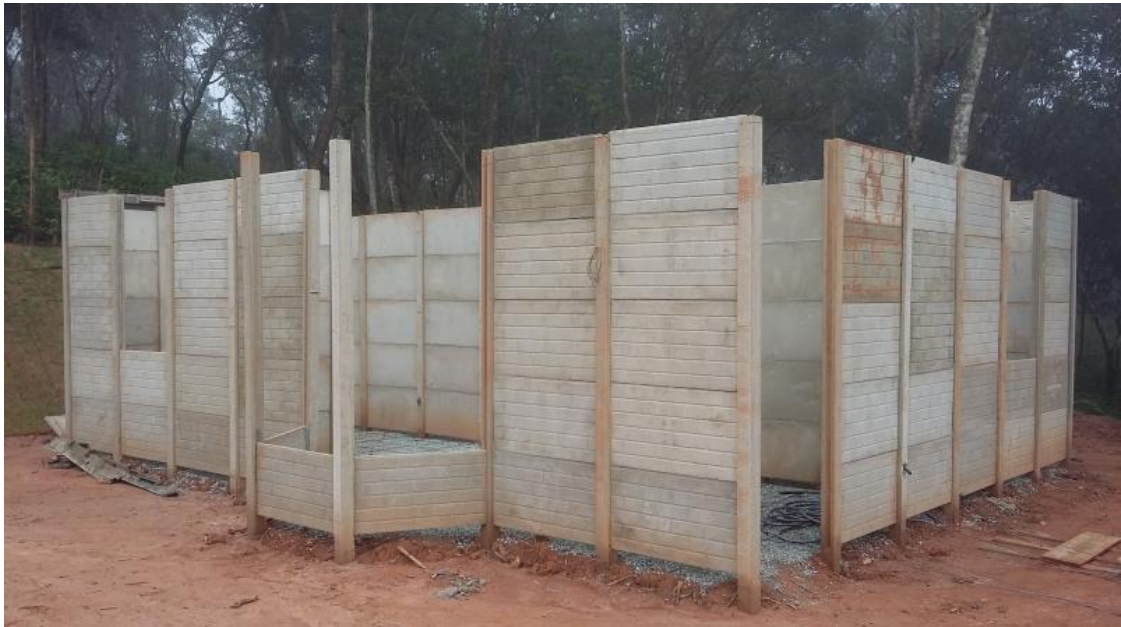
Figura 14: Casa pré-fabricada de concreto em execução
