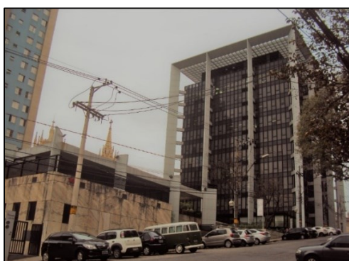
Figura 8: Edifícios sede e anexo
