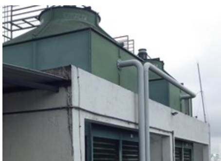
Figura 26: Torres de refrigeração
