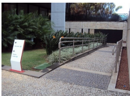
Figura 55: Rampa de acessibilidade
