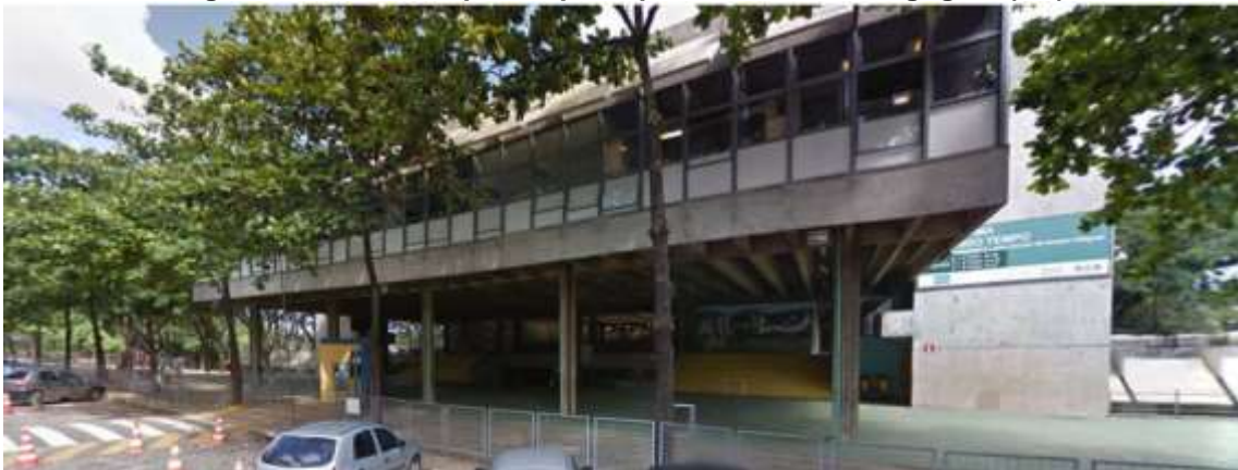
Figura 1 – Entrada e prédio principal do Centro Pedagógico (CP)
