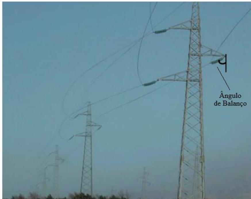
Figura 3-9. Balanço da cadeia de isoladores devido à ação do vento.
