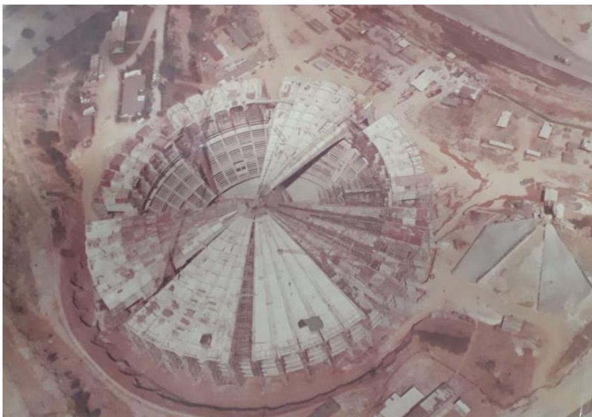
Figura 34 – O Palácio dos Esportes em construção visto de cima
