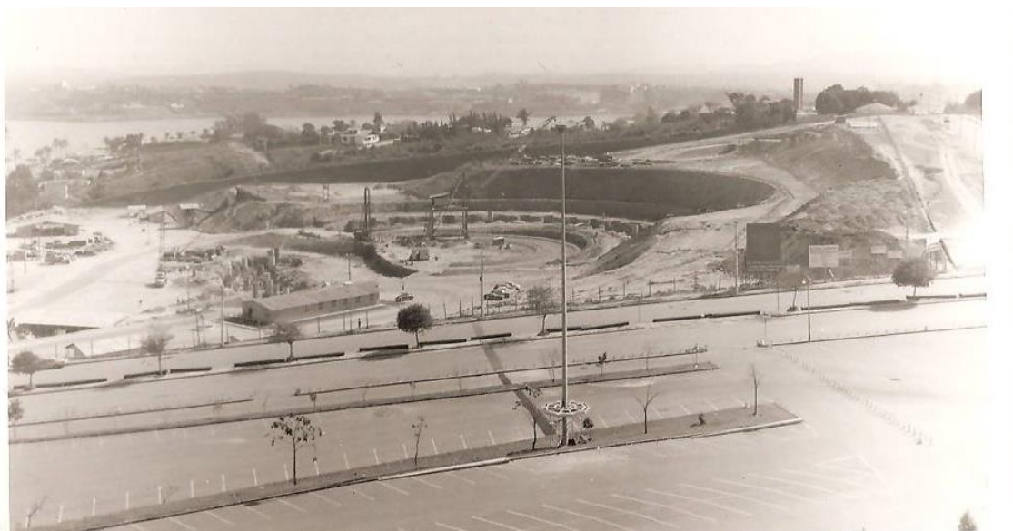
Figura 27 – Começou a construção: a fundação do Palácio
