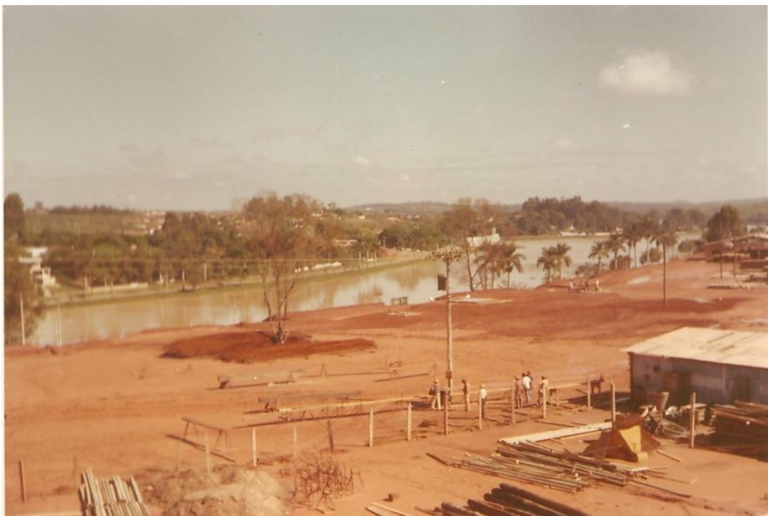
Figura 11 – O canteiro de obras do Mineirinho e a fundação
