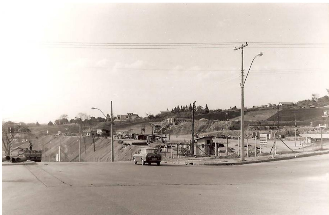
Figura 28 – A fundação do Palácio altera a paisagem
