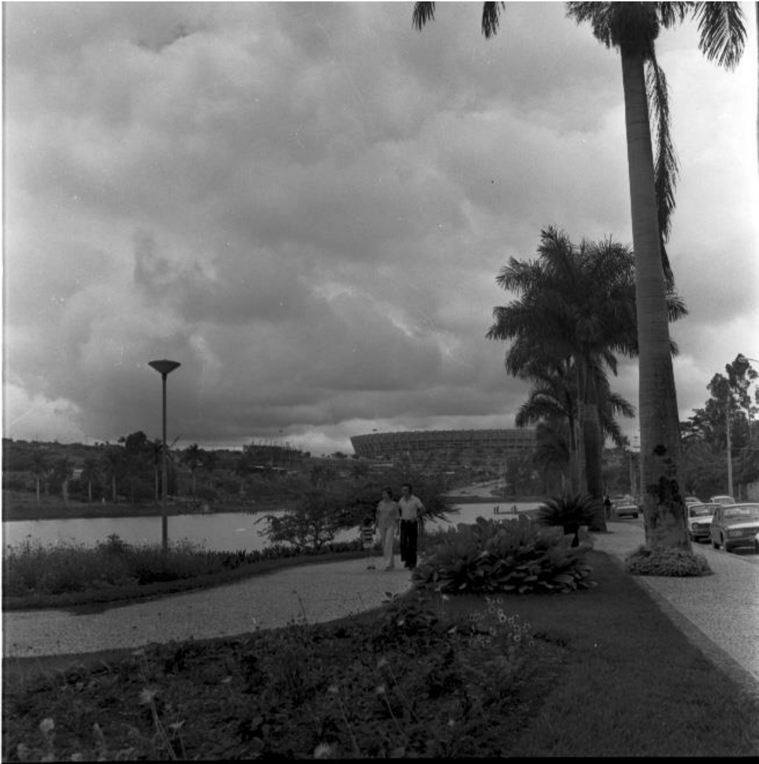
Figura 14 – A construção do Mineirinho vista de longe
