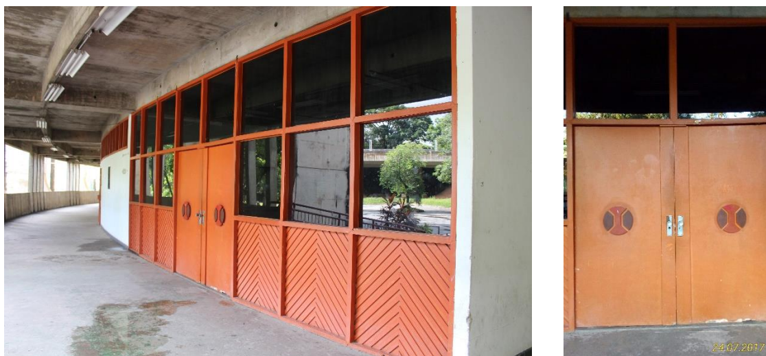
Figura 50 – Portaria que dava acesso ao alojamento do Mineirinho
