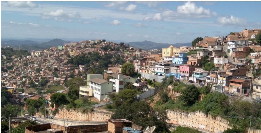
FIGURA 8 - Muro construído na Avenida do Cardoso
