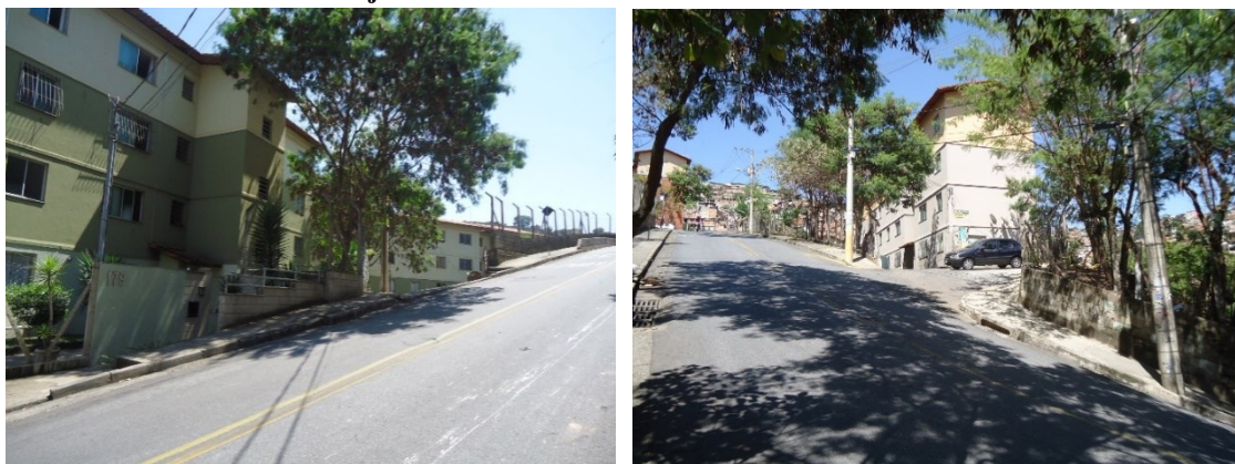
FIGURA 11 - Conjuntos Habitacionais na Rua São João e a declividade da rua
