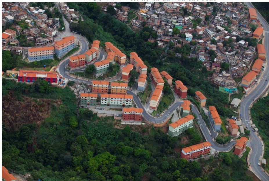
FIGURA 4 -Foto aérea da Rua São João
