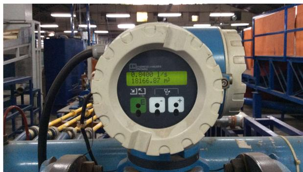
Ao atravessar um campo magnético cortando as linhas de campo, há o aparecimento de uma força eletromotriz no fluido proporcional a sua velocidade. Com o auxílio de um transmissor de vazão instalado na tubulação entre flanges, é possível aferir a descarga líquida correspondente (INCONTROL, 2011).
