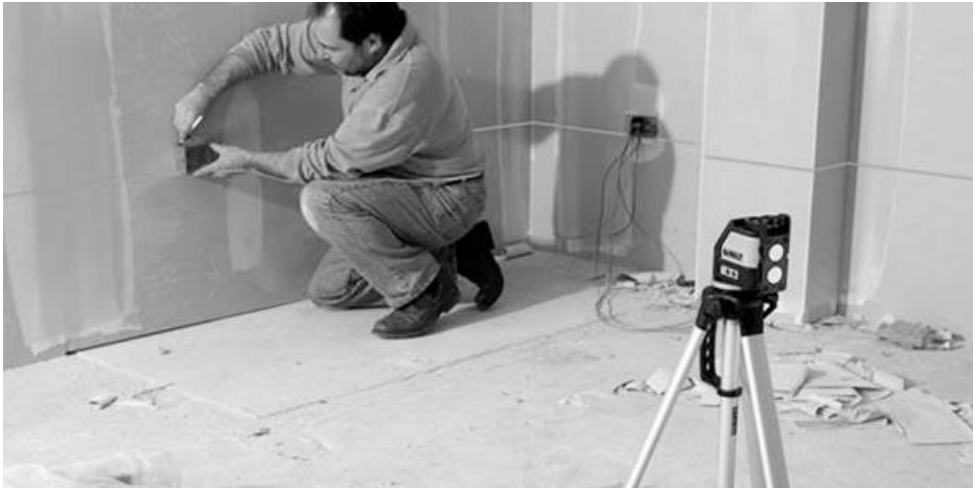
Figura 24: Nível a laser posicionado em cima do tripé. Fonte: Portal Pedreirão, 2012.
