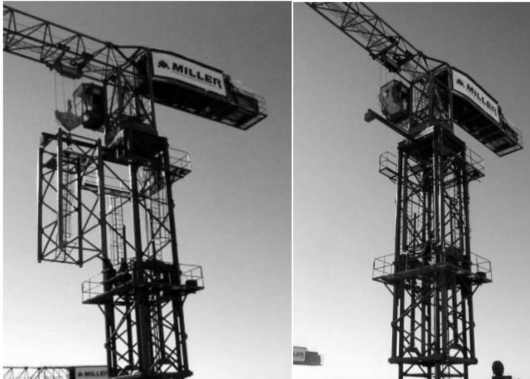
Figura 5: Pistões hidráulicos atuando para criar o vão e em seguida encaixando o módulo. Fonte: Blog Engenharia Estrutural e Construção Civil, 2012.
