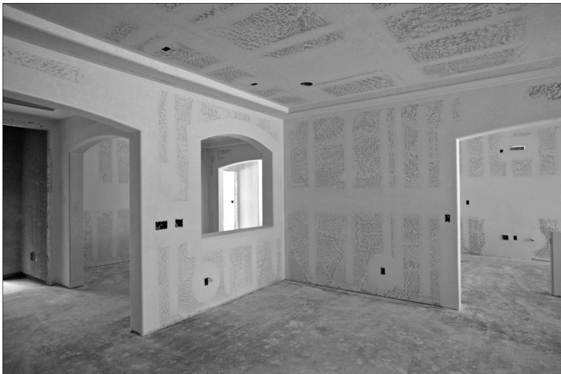
Figura 29: Sistema drywall em fase de acabamento. Fonte: Portal Dry Land Design.
