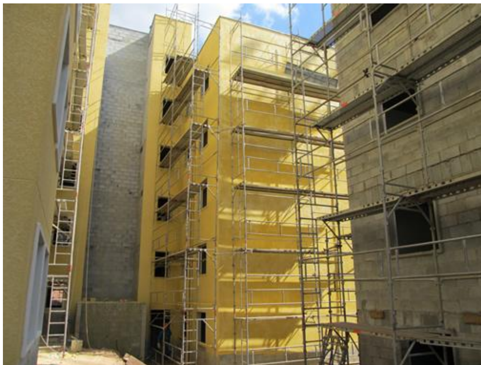
Figura 8: ARDM sendo aplicada em edifícios feitos com blocos de concreto. Fonte Portal AECweb.
