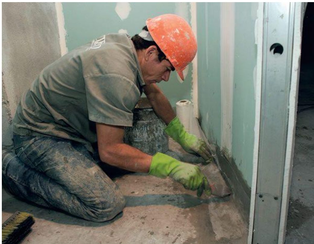
Figura 27: Execução de drywall em área molhada. Fonte: Portal Pedreirão, 2013.
