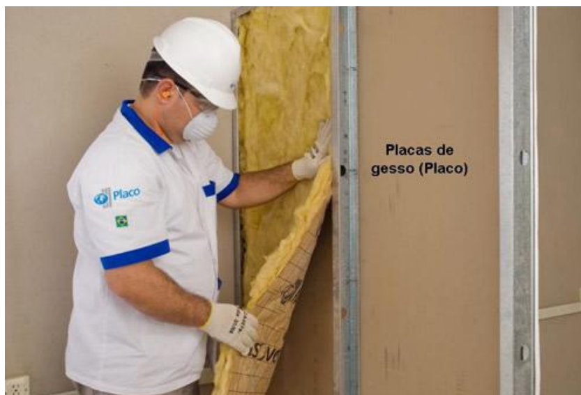
Figura 30: Aplicação de isolamento acústico no interior do sistema. Fonte: Portal Pedreira, 2013.
