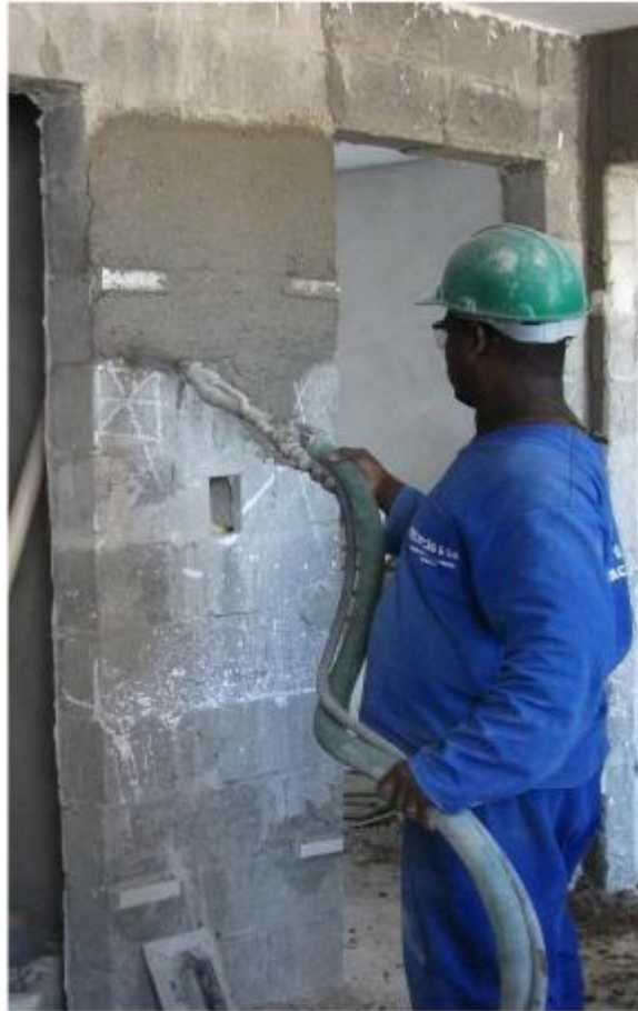
Figura 16: Argamassa sendo projetada. Sinduscon-BA.
