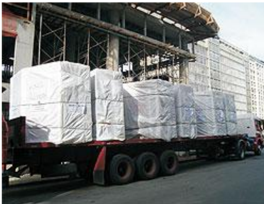
Figura 22: Banheiros sendo transportados. Fonte: Revista Techné, Ed. 159 junho/2010.
