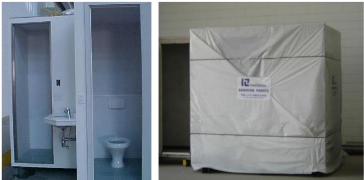
Figura 21: Banheiro pronto e em seguida embalado. Fonte: Revista Techné, Ed. 159 junho/2010.
