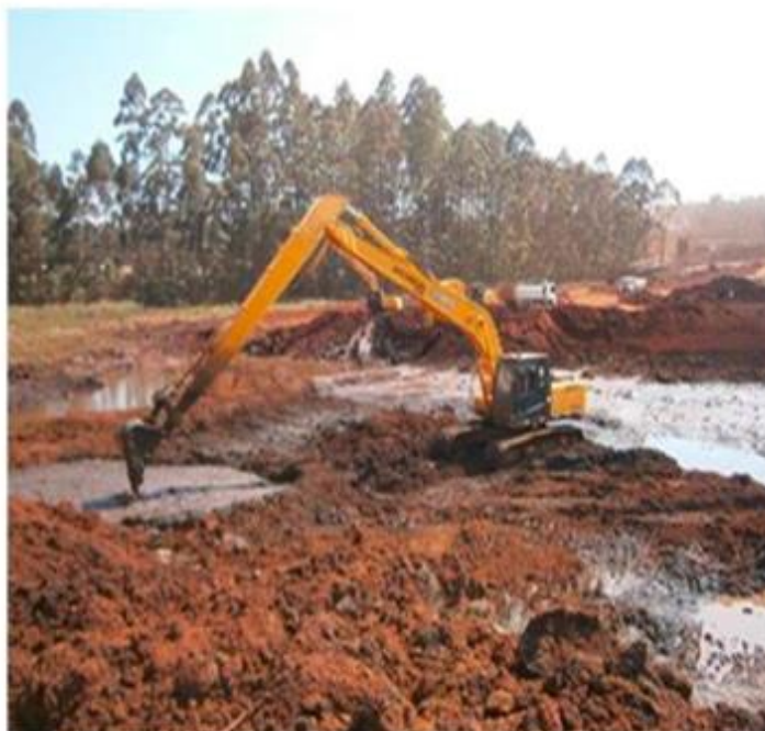
Figura 5 - Tratamento da Fundação
