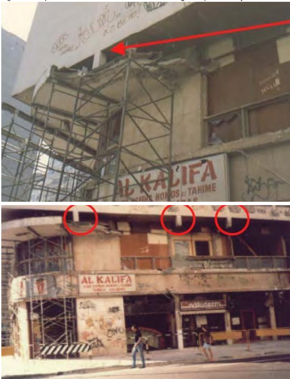
Figura 8: Marquise do edifício Mercúrio: escoramento emergencial para demolição.
