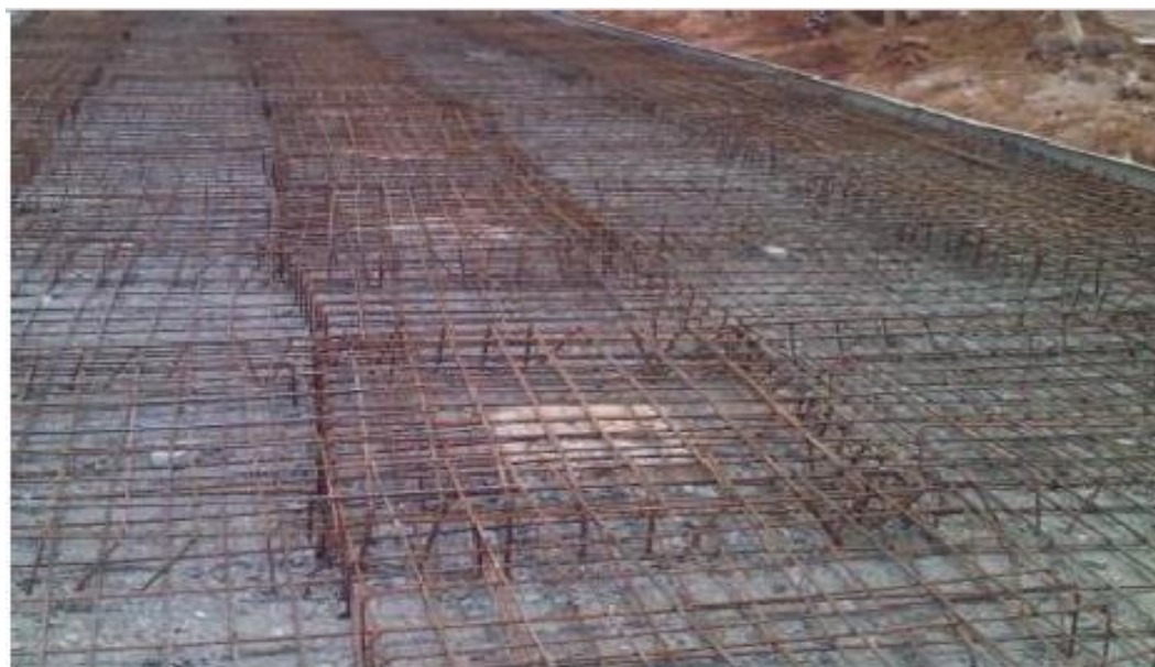
Figura 23 -: Armação positiva e negativa concluída Fonte: da pesquisa, 2015.
