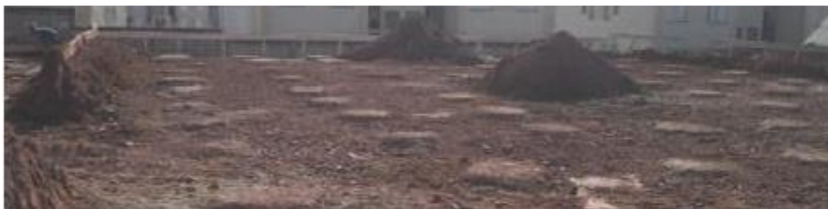
Figura 15 - Escavação finalizada e tubulões liberados
