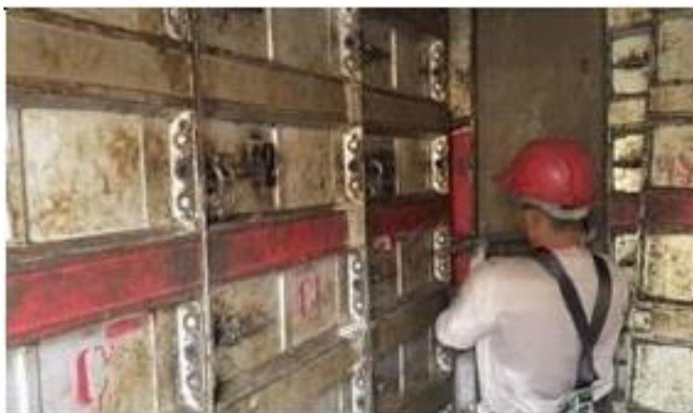
Figura 47 - Desforma da parede. Fonte: da pesquisa, 2015.
