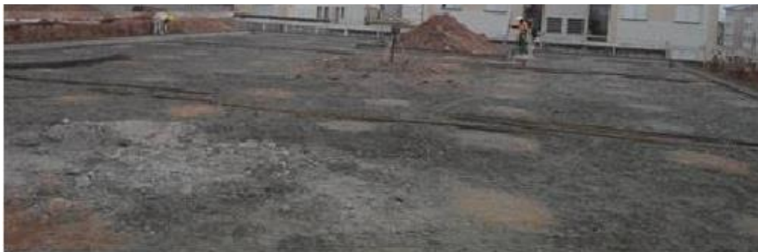
Figura 22 - Camada de brita corrida esp.5cm Fonte: da pesquisa, 2015.
