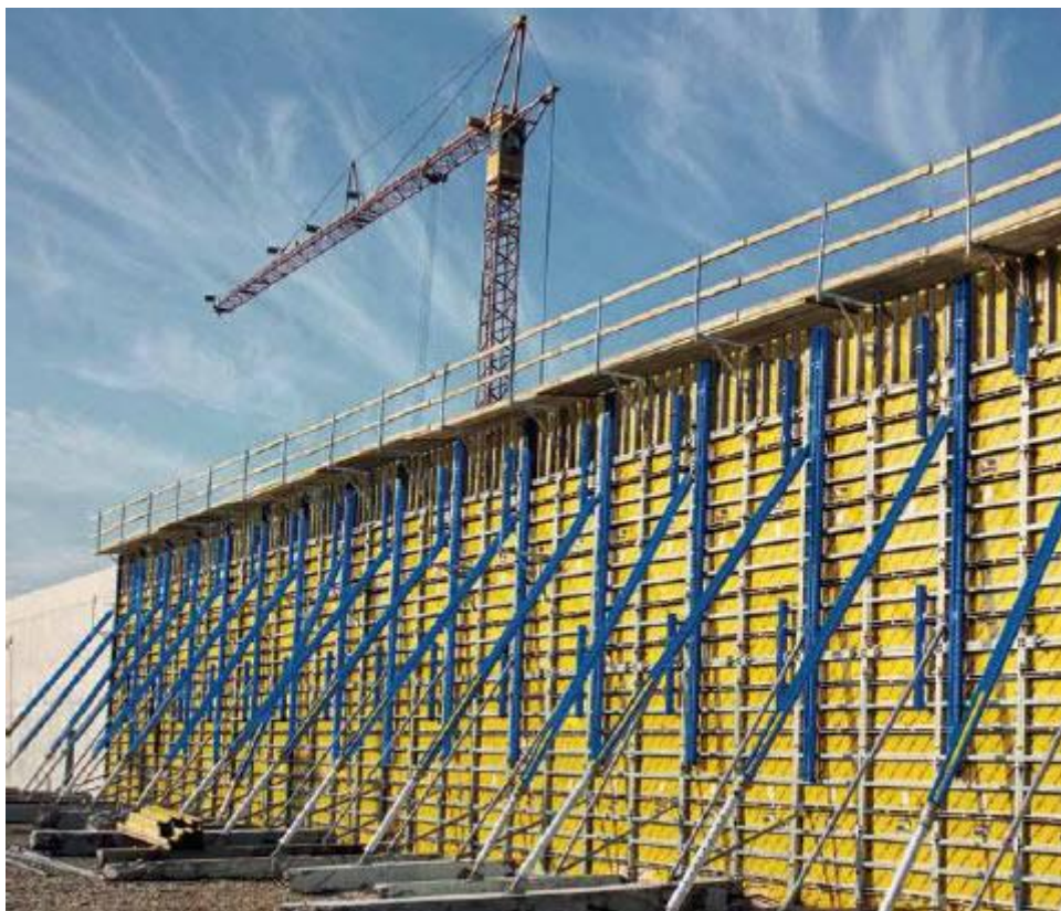
Figura 11 - Fôrma Doka Fonte: Alves e Peixoto, 2011
