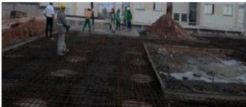
Figura 24 - Em processo de concretagem Fonte: da pesquisa, 2015.
