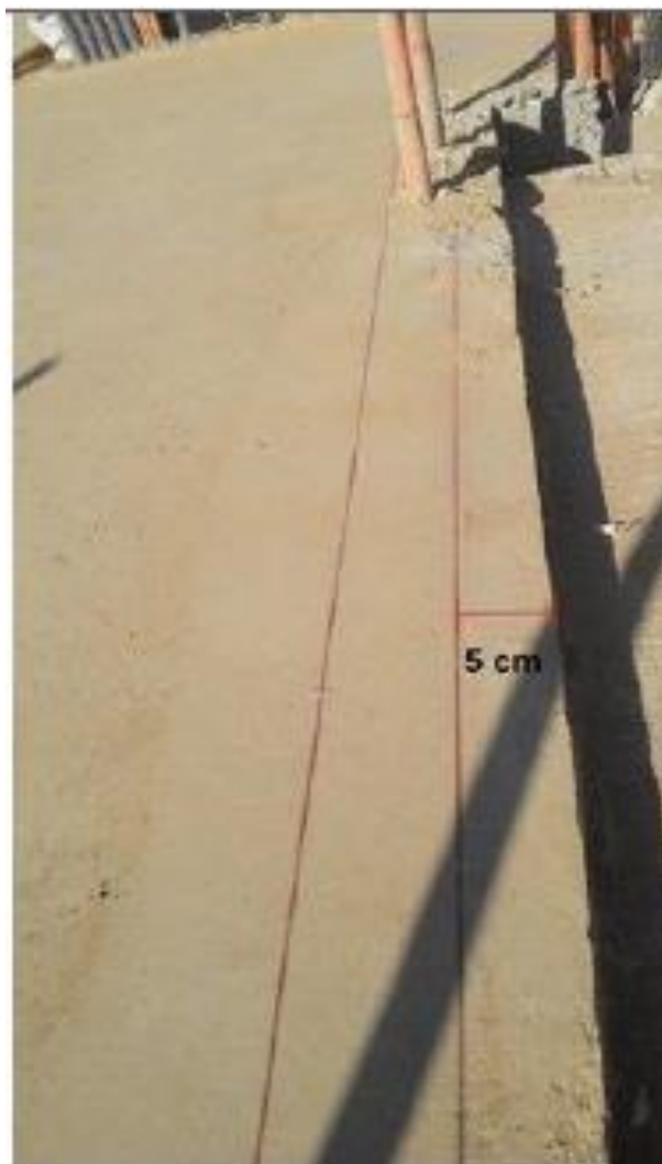
Figura 30 - Realização da marcação das paredes. Fonte: da pesquisa, 2015.
