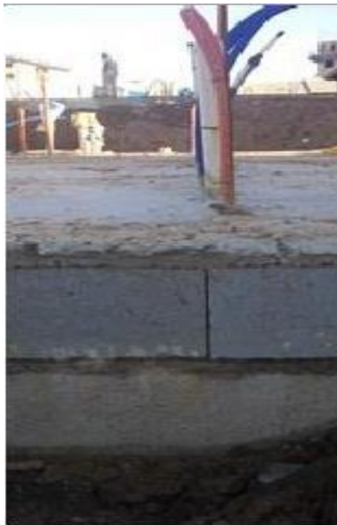
Figura 29 - Processos de concretagem da base concluídos. Fonte: da pesquisa, 2015.
