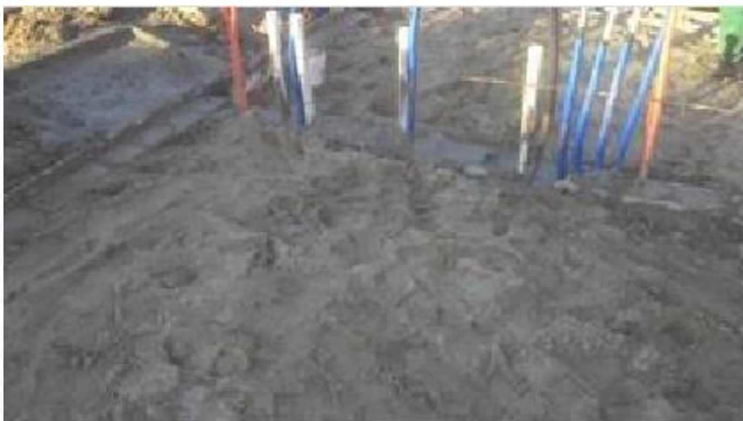
Figura 28 - Processo de Reaterro. Fonte: da pesquisa, 2015.
