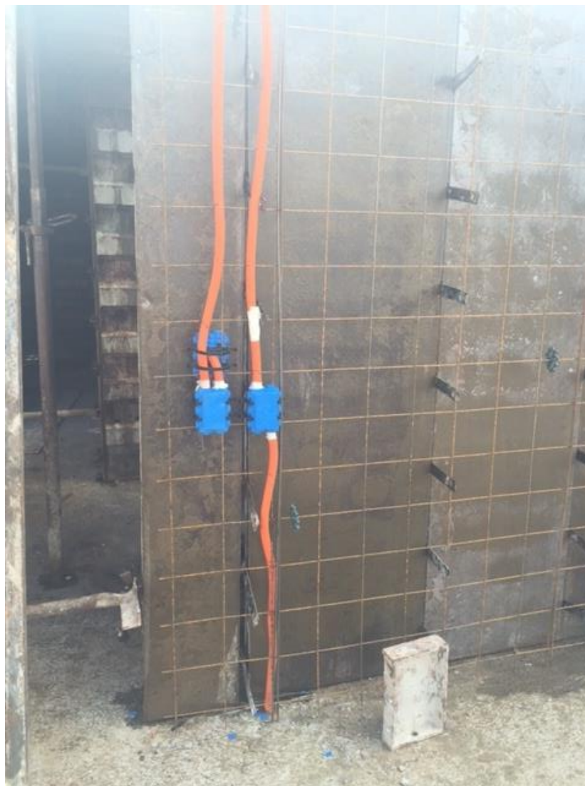
Figura 41 - Caixas especiais seladas. Fonte: Da pesquisa, 2015.
