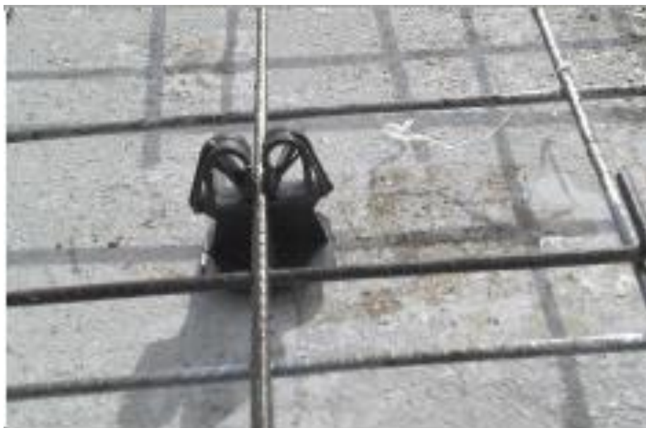
Figura 38 - Espaçador da laje Fonte: da pesquisa, 2015.
