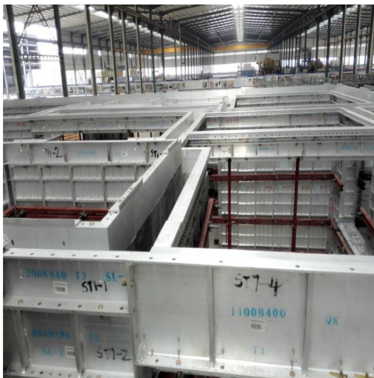
Figura 6 - Tipo de Fôrma de Alumínio Fonte: Mitidieri et al. (2012)
