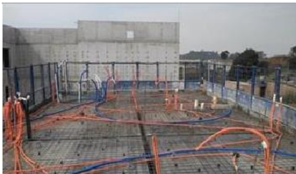
Figura 44 - Laje finalizada Fonte: da pesquisa, 2015.
