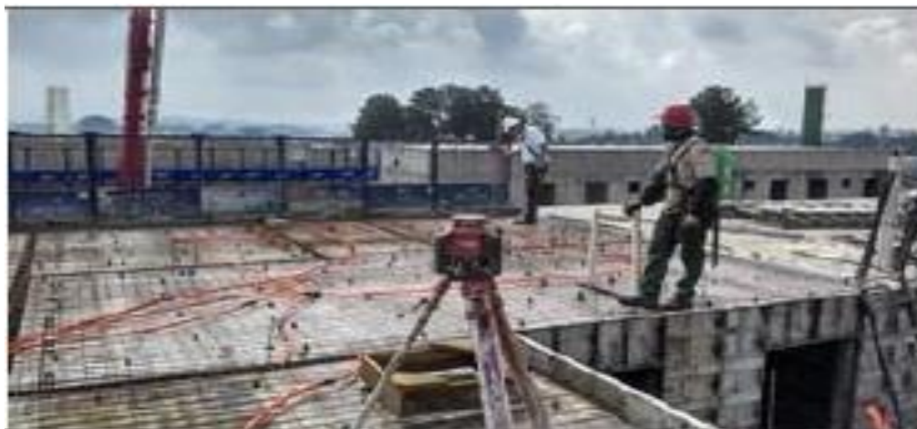
Figura 40 - Nivelamento das Fôrmas da laje com auxílio do nível Laser. Fonte: da pesquisa, 2015.
