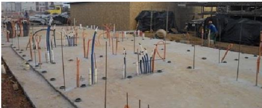
Figura 34 - Marcação da laje zero finalizada com espaçadores. Fonte: da pesquisa, 2015.
