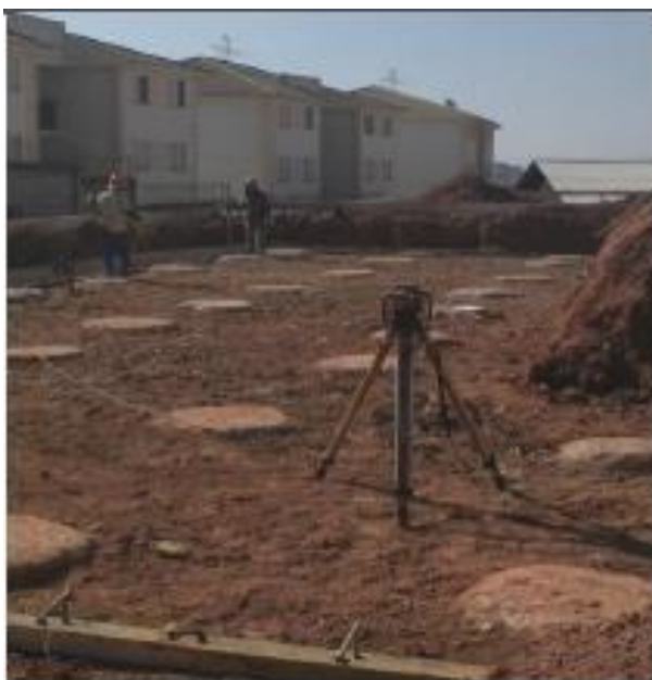
Figura 20 - Conferência do nível da forma com nível laser Fonte: da pesquisa, 2015.
