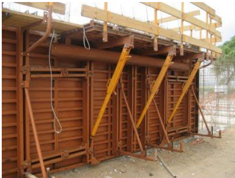
Figura 8 - Tipo de Fôrma HF Rohr Fonte: Faria, 2011
