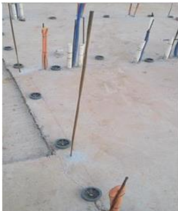
Figura 35 - Vergalhão auxiliar para amarração da armadura. Fonte: da pesquisa, 2015.
