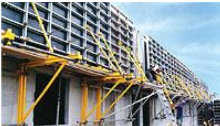
Figura 9 - Tipo de Fôrma Concreform – Morar SH Fonte: Faria, 2009
