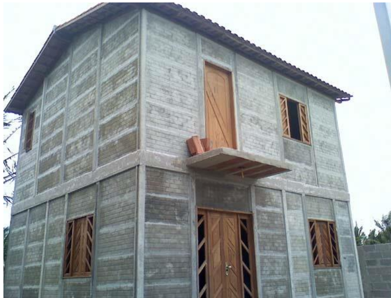
Figura 2 - Construção com pré-moldados Fonte: Cartwright, 2014
