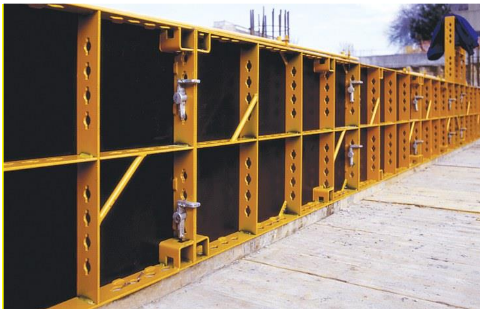
Figura 12 - Sistema Comain Ulma Fonte: Mitidieri et. al (2012)
