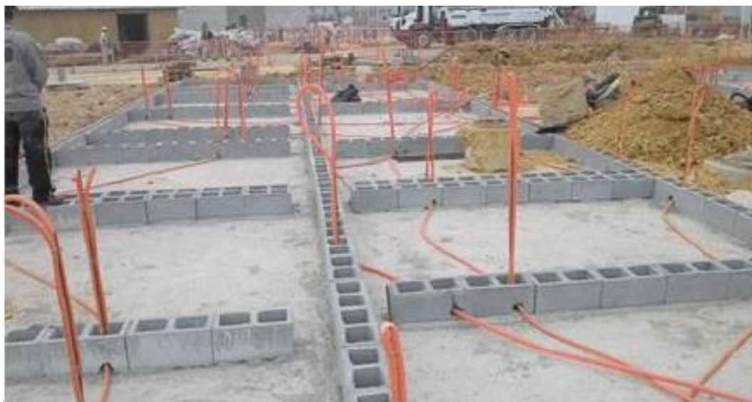
Figura 26 - Embasamento concluído. Iniciando passagens de Elétrica. Fonte: da pesquisa, 2015.
