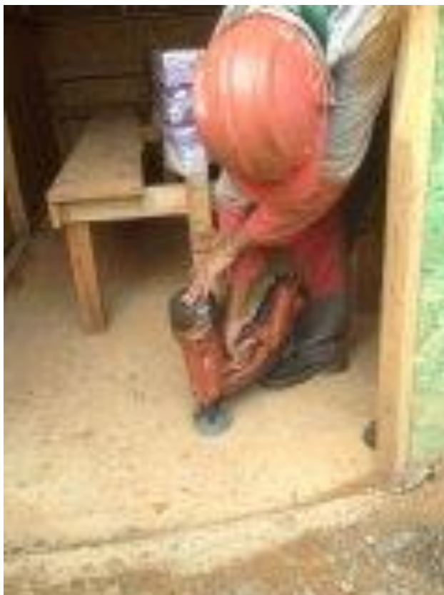
Figura 33 – Grampeamento utilizando finca pino. Fonte: da pesquisa, 2015.
