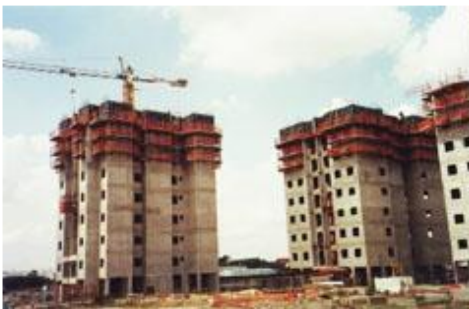
Figura 4 - Projeto Viver - Utilização de paredes de concreto moldadas no local Fonte: HESKETH,2010
