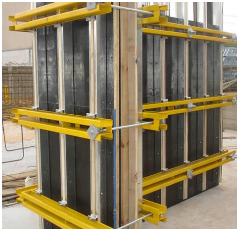
Figura 10 - Fôrma leve Pashal Fonte: Mitidieri et al. (2012)
