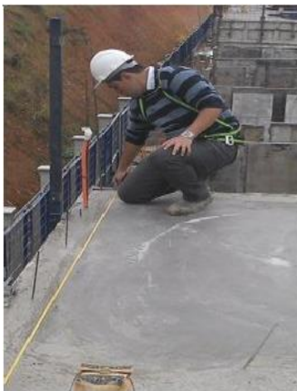
Figura 32 - Marcação das medidas internas do apartamento com trena metálica Fonte: da pesquisa, 2015.
