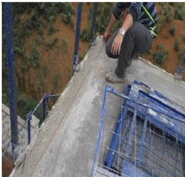
Figura 31 - Encarregado fazendo marcação com a corda Fonte: da pesquisa, 2015.
