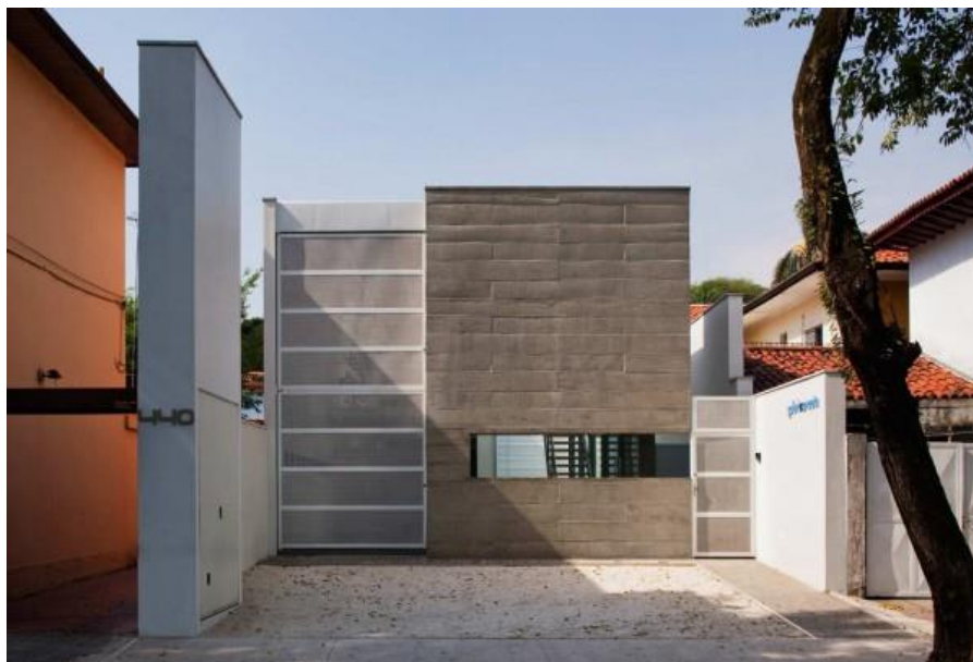
Figura 3 - Construção de parede moldada “in loco” Fonte: Cartwright, 2014
