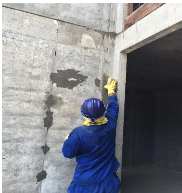
Figura 13 - Execução de feltragem Fonte: da pesquisa, 2015
