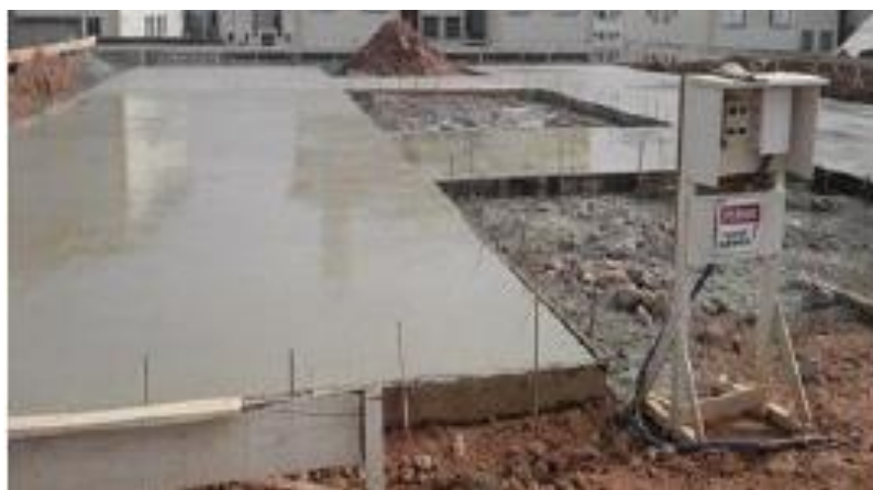
Figura 25 - Concretagem da base concluída Fonte: da pesquisa, 2015.
