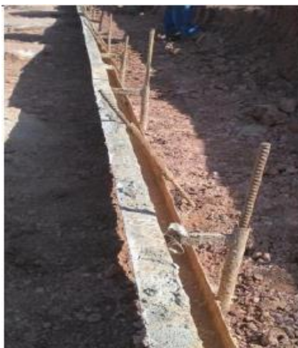
Figura 19 - Travamento da Fôrma. Fonte: da pesquisa, 2015.
