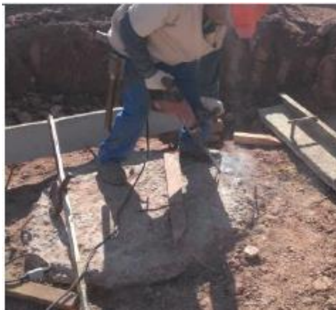
Figura 16 - Regularização e limpeza dos tubulões. Fonte; da pesquisa, 2015.
