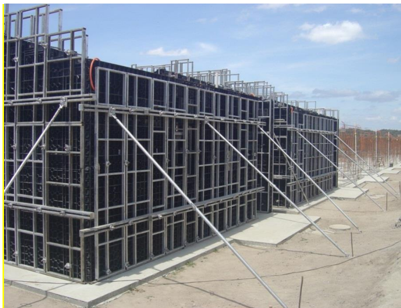
Figura 7 - Tipo de Fôrma Metroform Fonte: Martin (2010)
