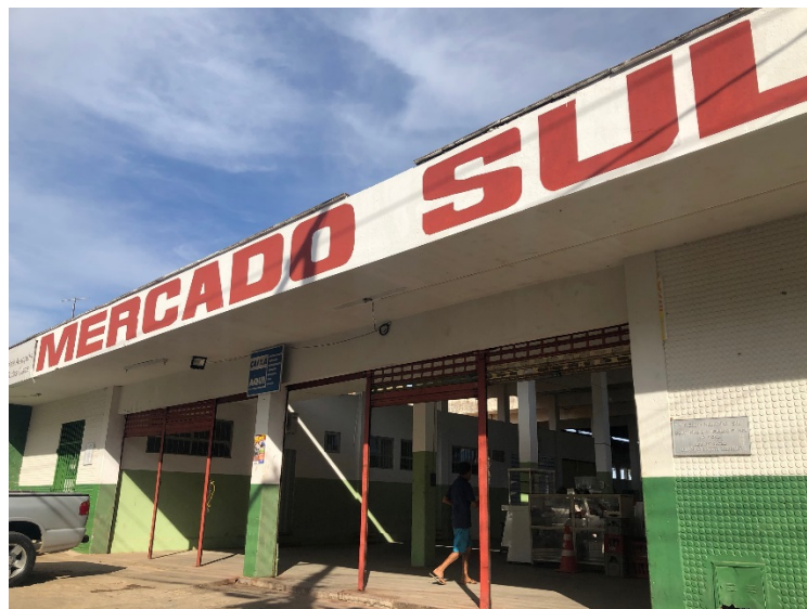
Figura 19 - Fachada principal do Mercado Sul, Montes Claros
