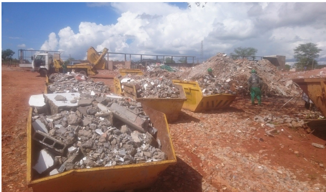
Figura 11: Aterro Particular de recebimento de RCC. Fonte: Global Caçambas, 2019.
