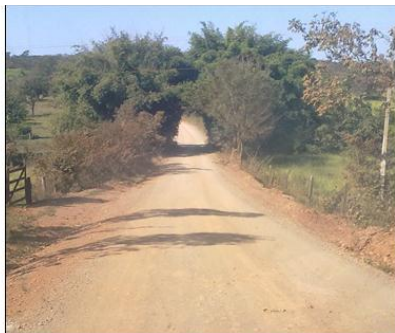
Figura 2 – Percurso aplainado após uma terraplanagem
