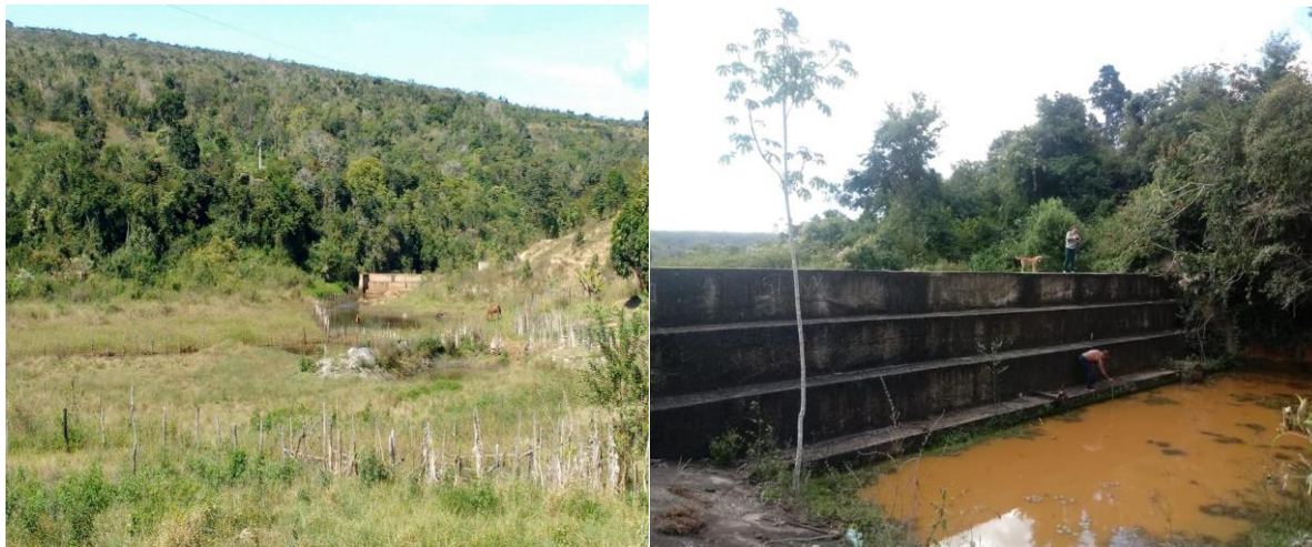
FIGURA 8 - BARRAGEM DA COMUNIDADE CRAUNILHA
