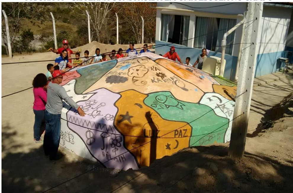
FIGURA 16 - CISTERNA CONSTRUÍDA EM UMA ESCOLA NO CAMPO
