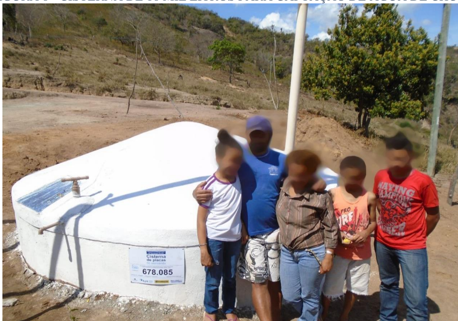
FIGURA 6 - CISTERNA DE 16 MIL LITROS PARA CAPTAÇÃO DE ÁGUA DE CHUVA
