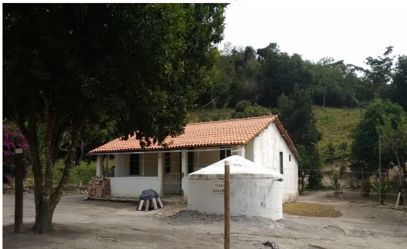
FIGURA 10 - CISTERNA DE PLACA PARA CAPTAÇÃO DE ÁGUA DA CHUVA NA COMUNIDADE FAZENDA NOVA
