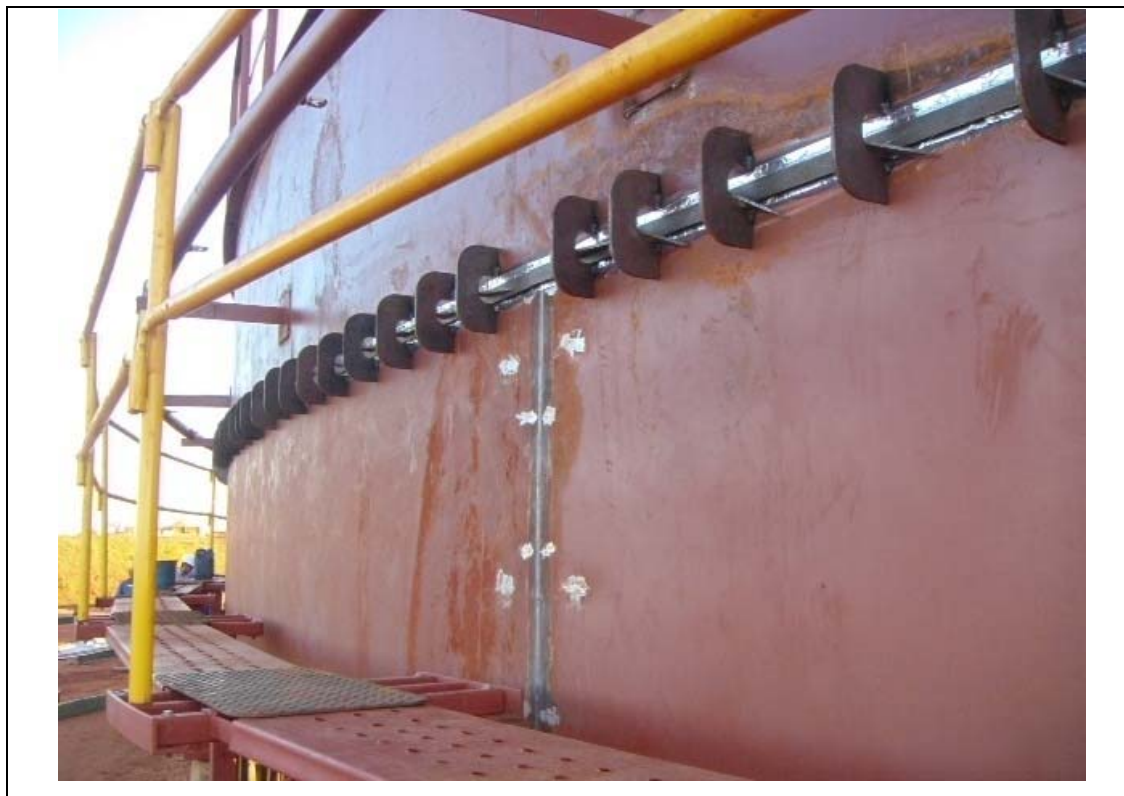
Figura 24: Atracação da junta horizontal. Autores
