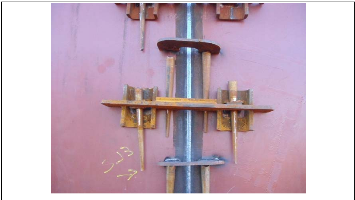
Figura 23: Atracação de juntas verticais. Autores
