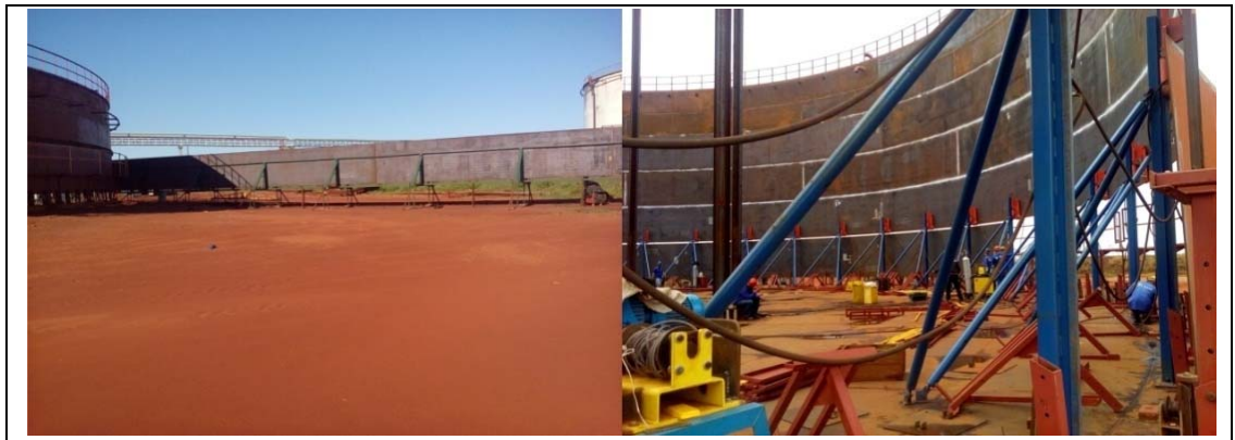
Figura 16: Montagem de tanques com magazine. Autores
