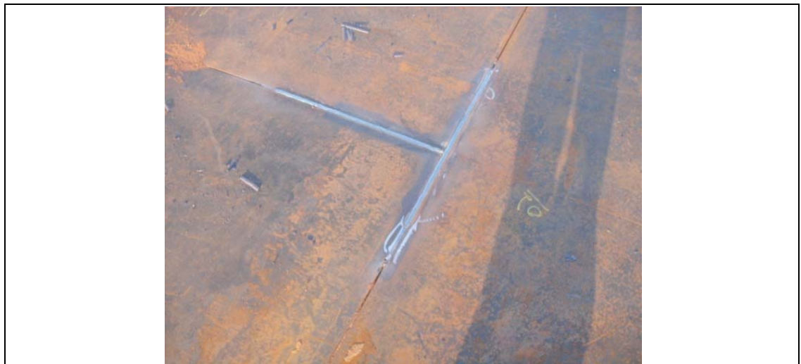
Figura 19: Travamento das chapas do fundo. Autores
