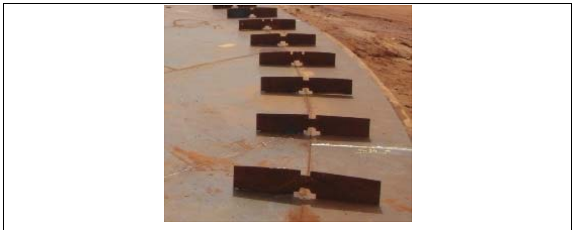
Figura 22: Travamento das juntas anulares com fundo. Autores
