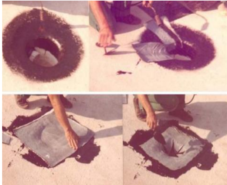
Figura 27 – Impermeabilização junto ao ralo Fonte: http://www.reformafacil.com.br , 2012
