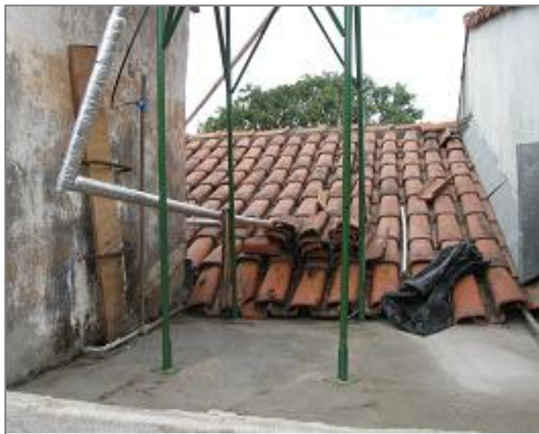
Figura 18 – Laje do banheiro, área externa Fonte: Residência em Belo Horizonte, 2012
