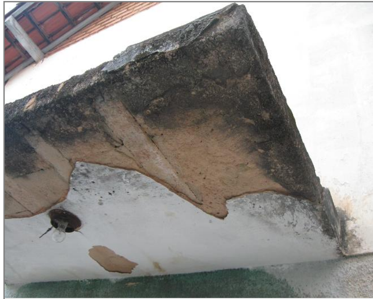
Figura 20 – Marquise garagem Fonte: Residência em Belo Horizonte, 2012
