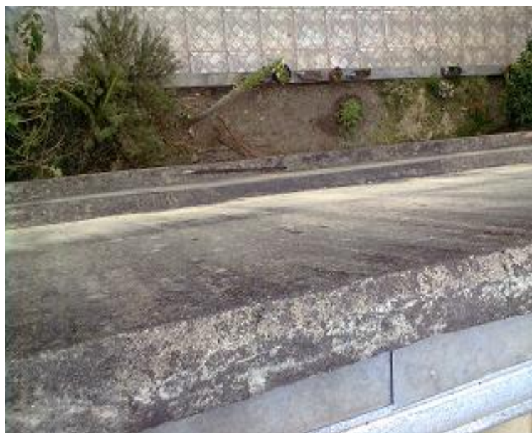
Figura 24 – Parede residência dos fundos, vizinho Fonte: Residência em Belo Horizonte, 2012
