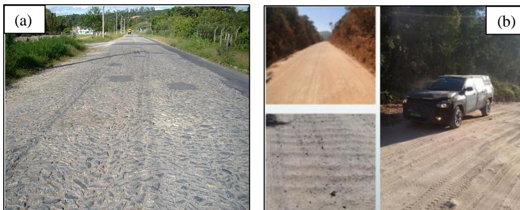
FIGURA 2.21 – Tipos de pavimentos utilizados no LDS - (a) Calçamento de pedra; (b) Percurso de terra.
