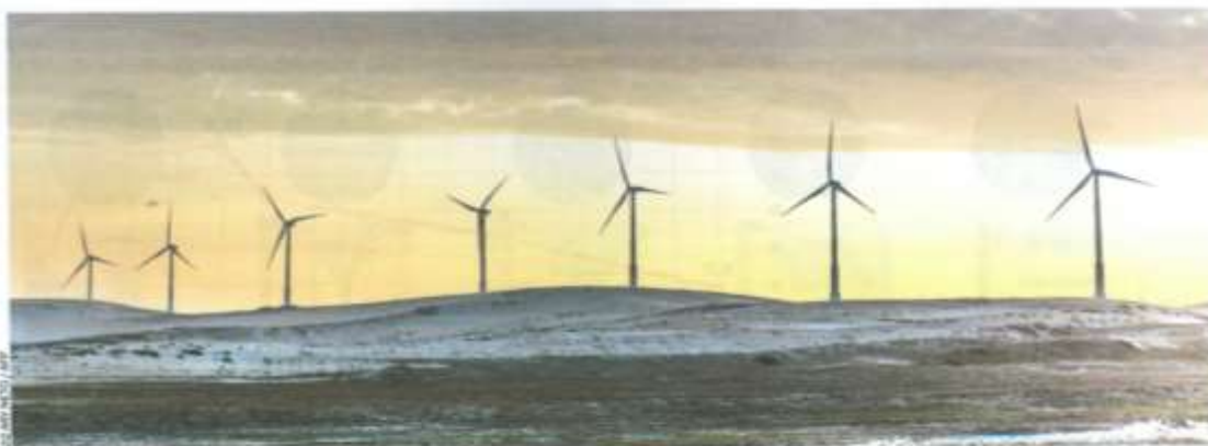
BONS VENTOS Turbinas eólicas para produzir eletricidade, em Talba, no litoral do Ceará, um dos principais produtores dessa energia no Nordeste
