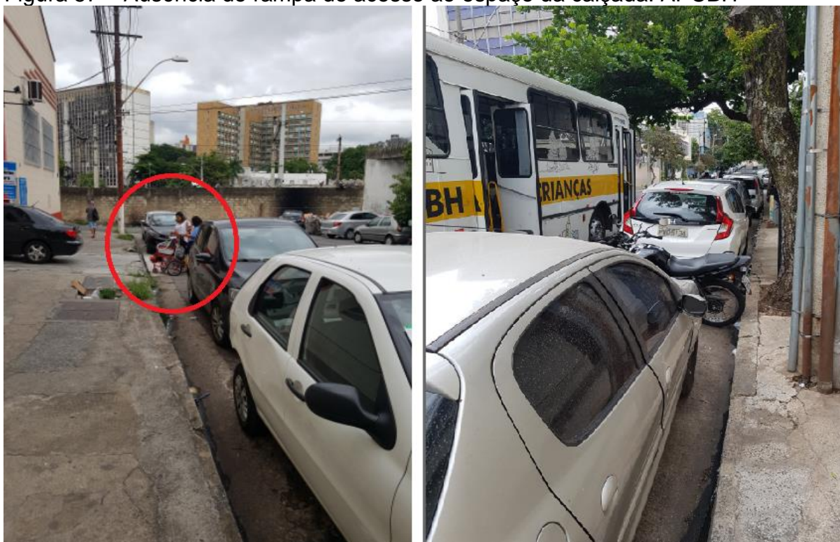
Figura 57 – Ausência de rampa de acesso ao espaço da calçada: APCBH
