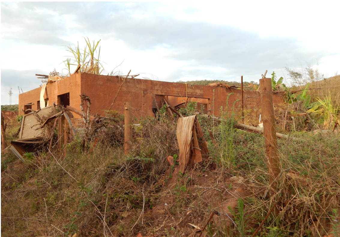
Figura 6) – Ruínas de uma casa em Bento Rodrigues Fonte: Arquivo Pesquisadora – 28/09/2017
