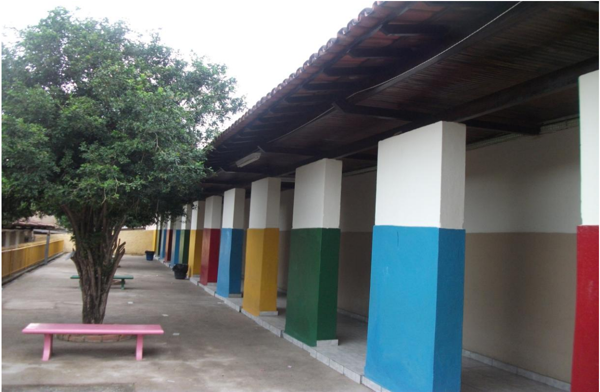
Vista parcial do pátio da escola
