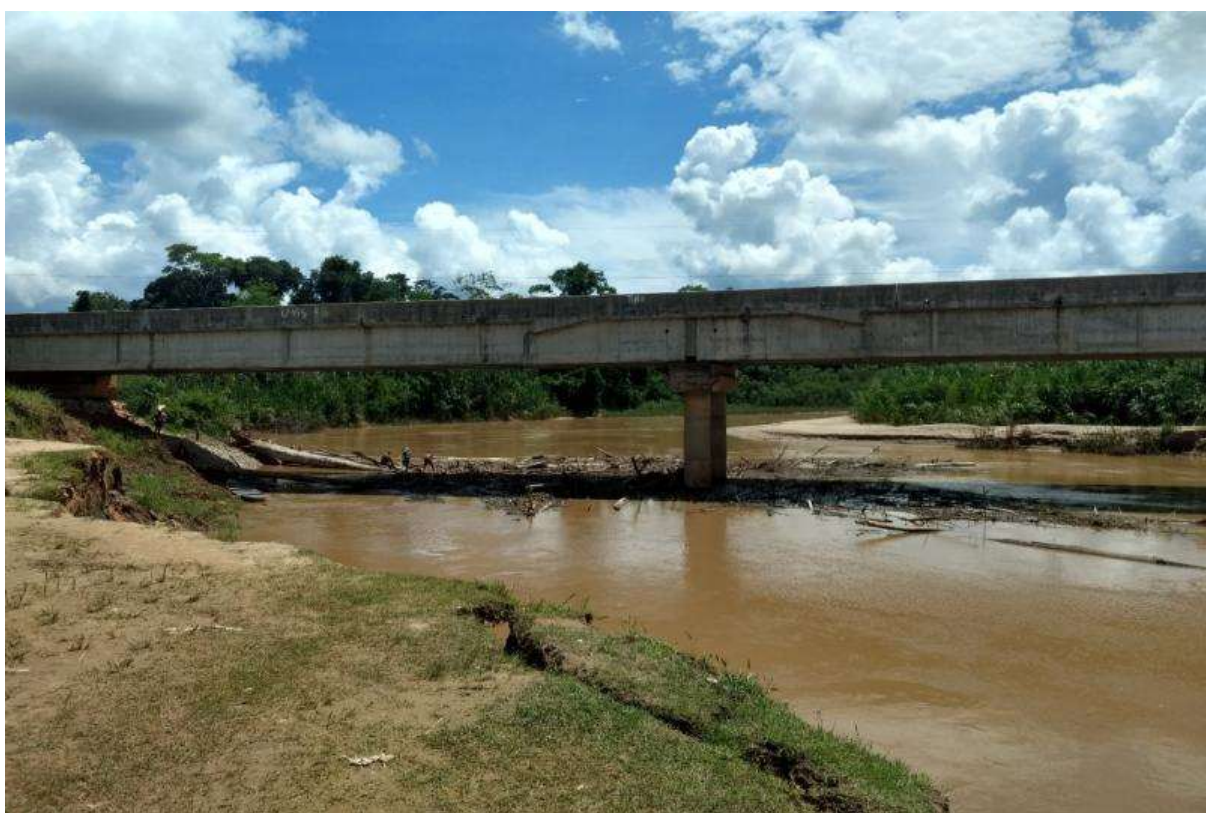
Figura 7 - Ponte sobre o Rio Gregorio no Vilarejo São Vicente
