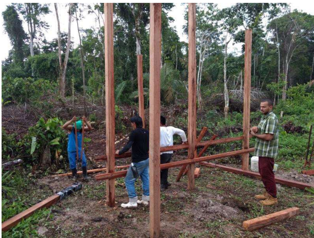
Figura 52 - Mutirão para a construção do banheiro seco
