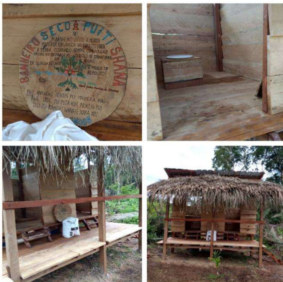
Figura 54 - Banheiro seco finalizado
