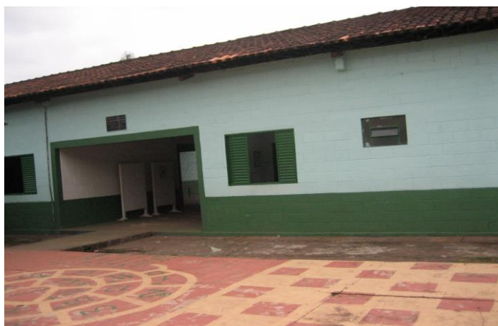
Figura 6 - Escola Municipal de Bento Rodrigues antes da reforma de 2010
