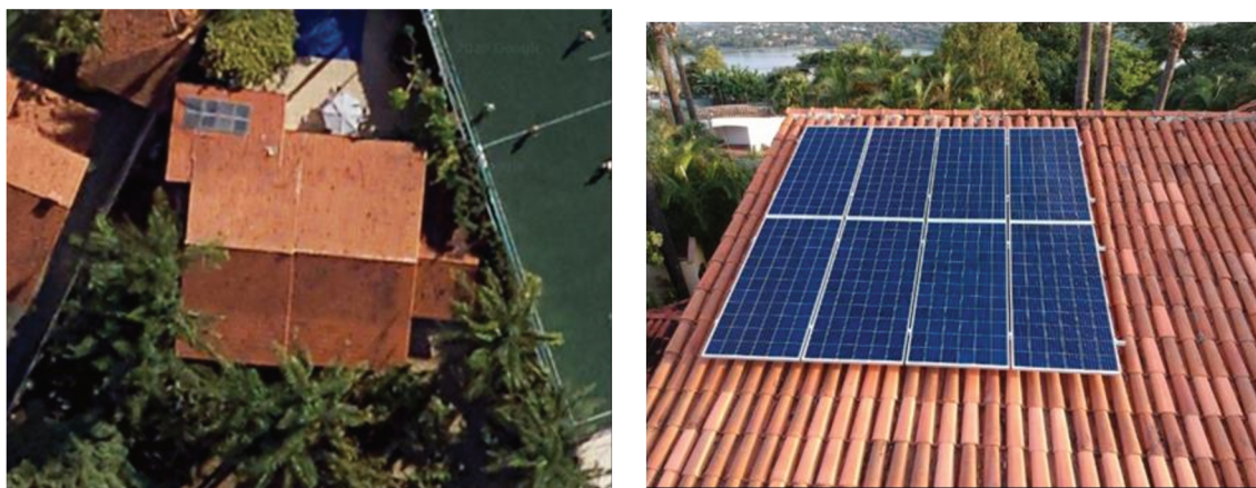
Figura 53: Local da instalação e lay-out dos módulos no telhado
