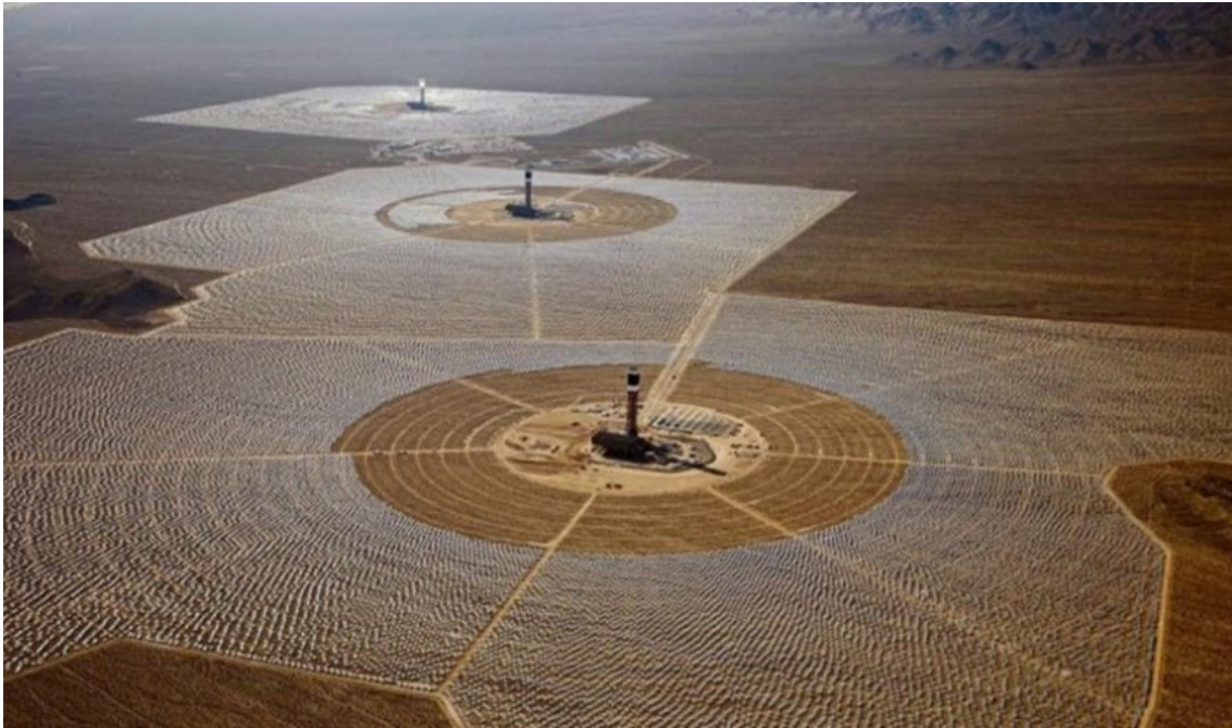
Figura 2 - Complexo de usinas de torre central, Ivanpah, na Califórnia, EUA.
