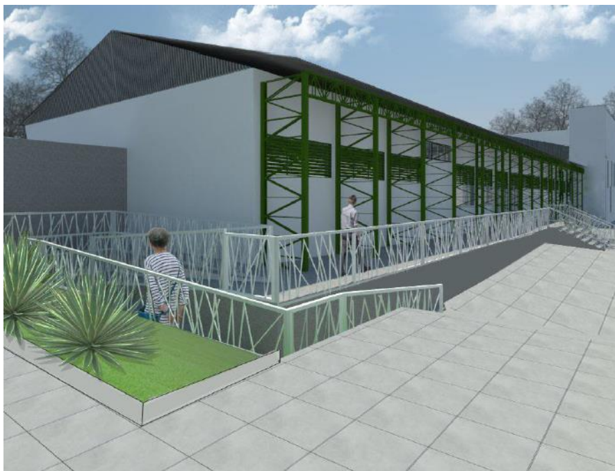
FIGURA 26- VISTA LATERAL ESQUERDA DO PROJETO DE REFORMA DA ACADEMIA OLGUIN (DESTAQUE PARA PISO,RAMPAS, E GUARDA-CORPOS NOVOS)
