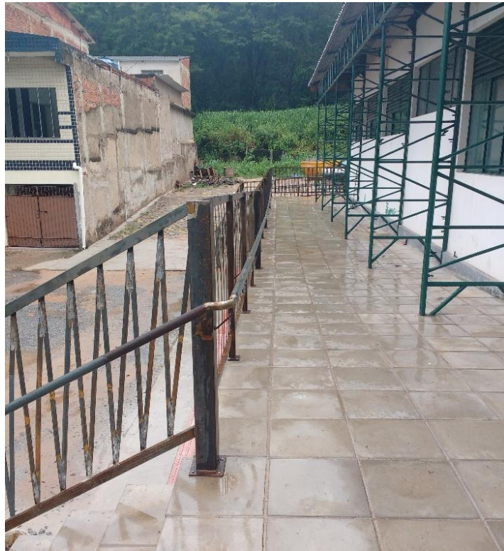
FIGURA 41 - GUARDA CORPO EXECUTADO
