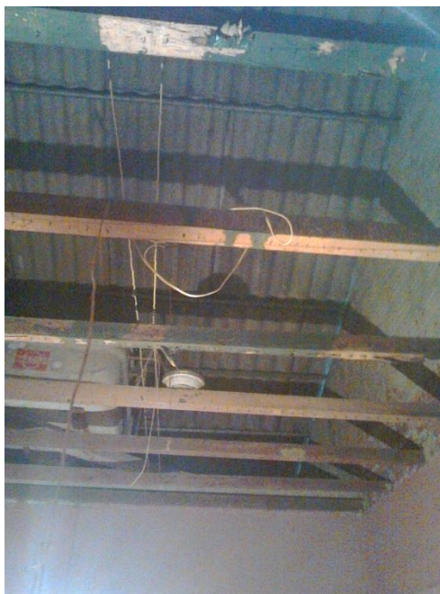
FIGURA 6- AUSÊNCIA DE FORO NOS CAMARINS, O MESMO FOI TOMADO POR XILÓFAGOS E FOI RETIRADO
