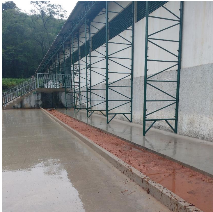
FIGURA 42 - NOVO PAISAGISMO DA FACHADA
