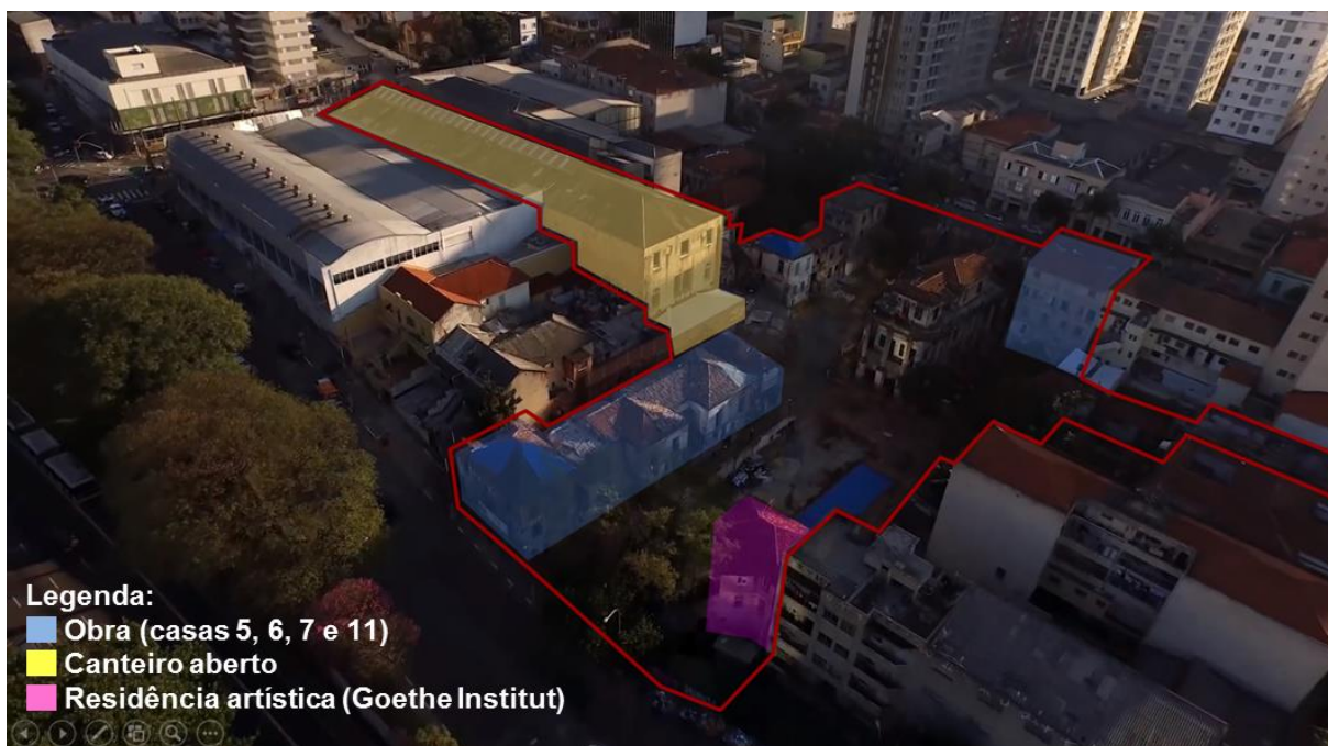
Figura 20 - Edificações em processo de restauro.
