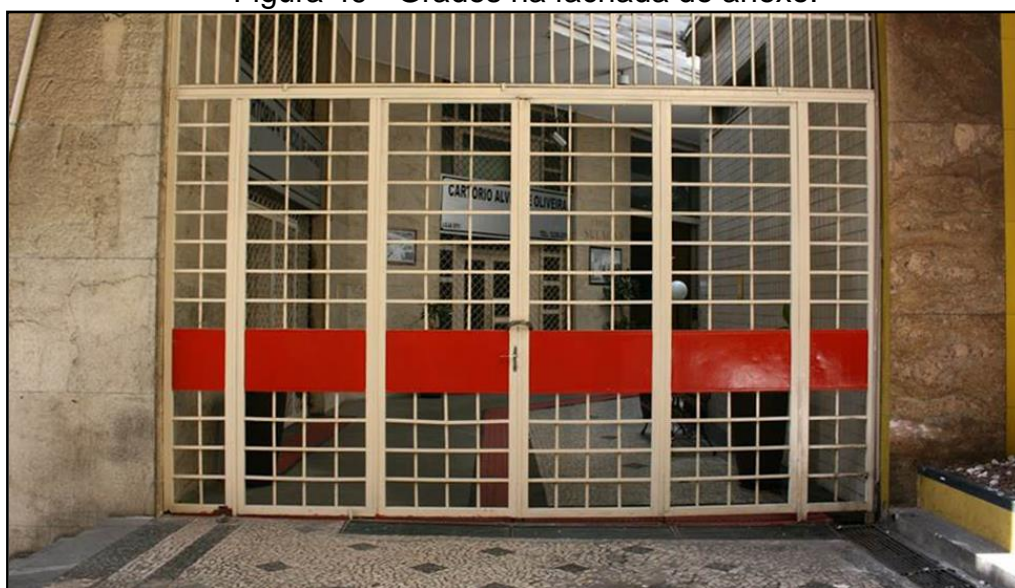
Figura 49 - Grades na fachada do anexo.
