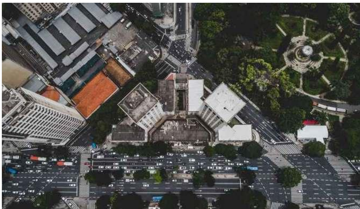
Figura 54 – Vista aérea do conjunto Sulacap SulAmérica
