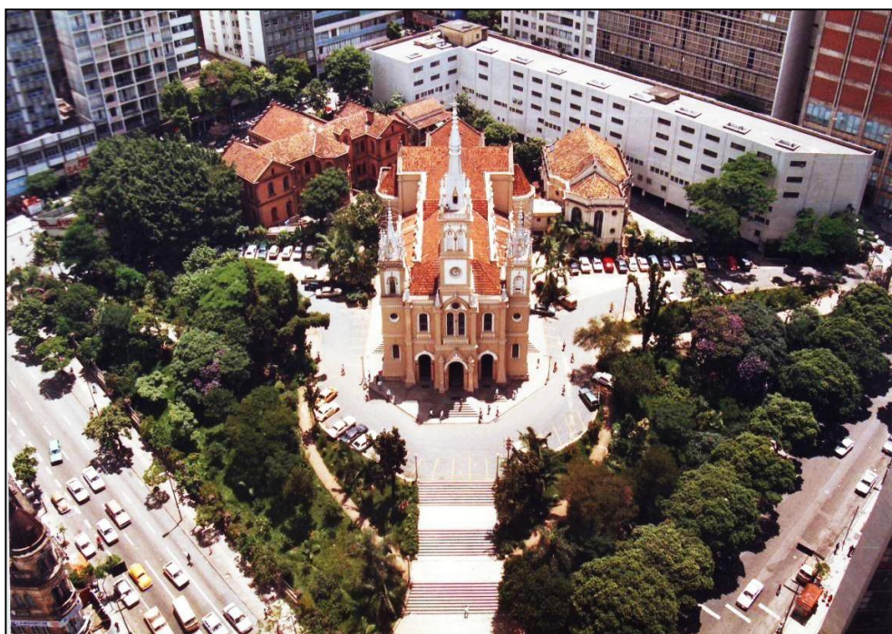
Figura 3 - Igreja São José em 1990 e a nova edificação (à direita, ao fundo).
