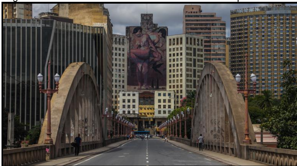
Figura 33 - Viaduto de Santa Tereza. Ao fundo Sulacap Sulamérica.
