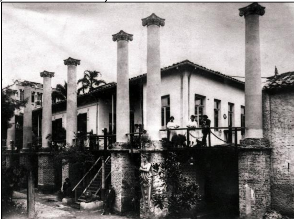
Figura 9 - Primeira edificação da Vila - Residência Embrião do Palacete.
