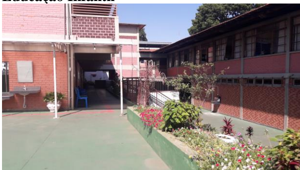
Foto 7- Pátio de acesso ao prédio da Educação Infantil
