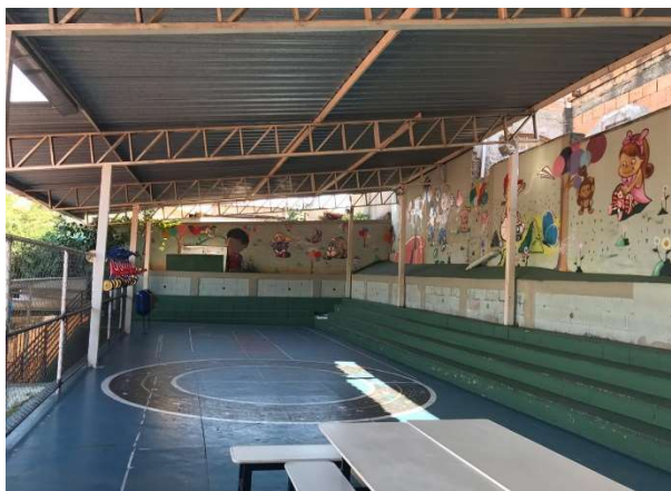
Figura 8 – Vista da quadra coberta
