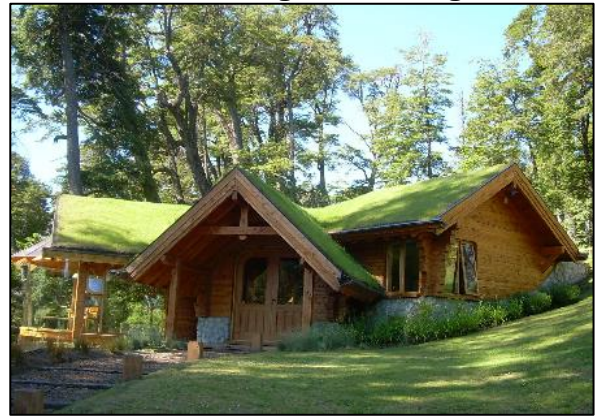
Figura 4.7 - Cobertura Inclinada - Villa la Angostura, Argentina
