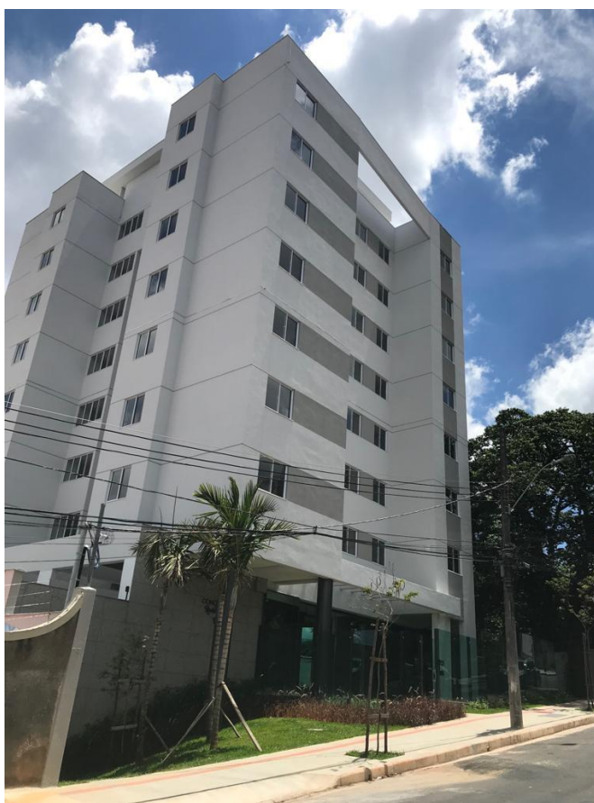
Figura 10: Empreendimento finalizado - vista das fachadas frontal e lateral
