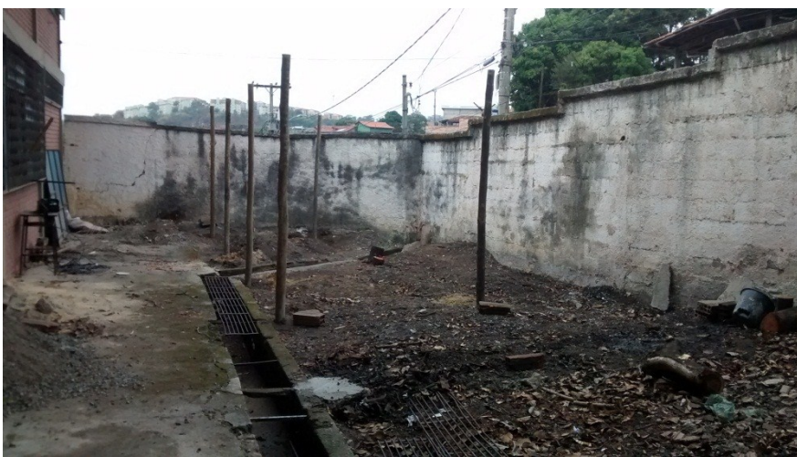
Figura 1 - Instalação das estruturas e limpeza do local.
