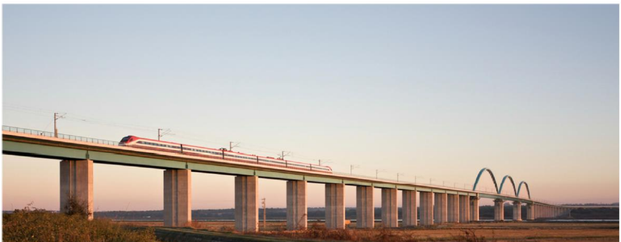
Figura 3.1: Vista da estrutura ferroviária em Alcácer do Sal. Fonte: Mourão (2010) apud Alencar (2016a)
