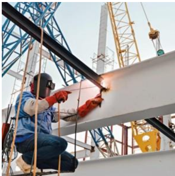
Figura 2.18: Exemplo de processo de soldagem em campo. Fonte: < http://editoralamonica.com.br/estabilidade-nas-construcoes/ >
